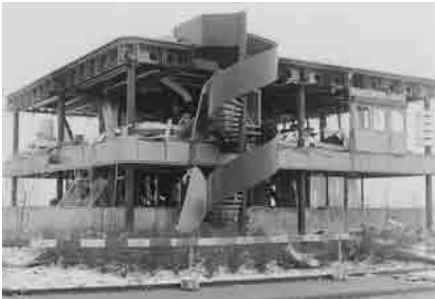
Abb. 16 und 17: Die Fotografien zeigen den 1976 gebauten Informationspavillon kurz nach seiner Fertigstellung und am Tag nach dem Sprengstoffanschlag vom 19. Februar 1979. Quellen: KWK, Geschäftsbericht 1976; AKS, Aurica, Zerstörung Info-Pavillon.
