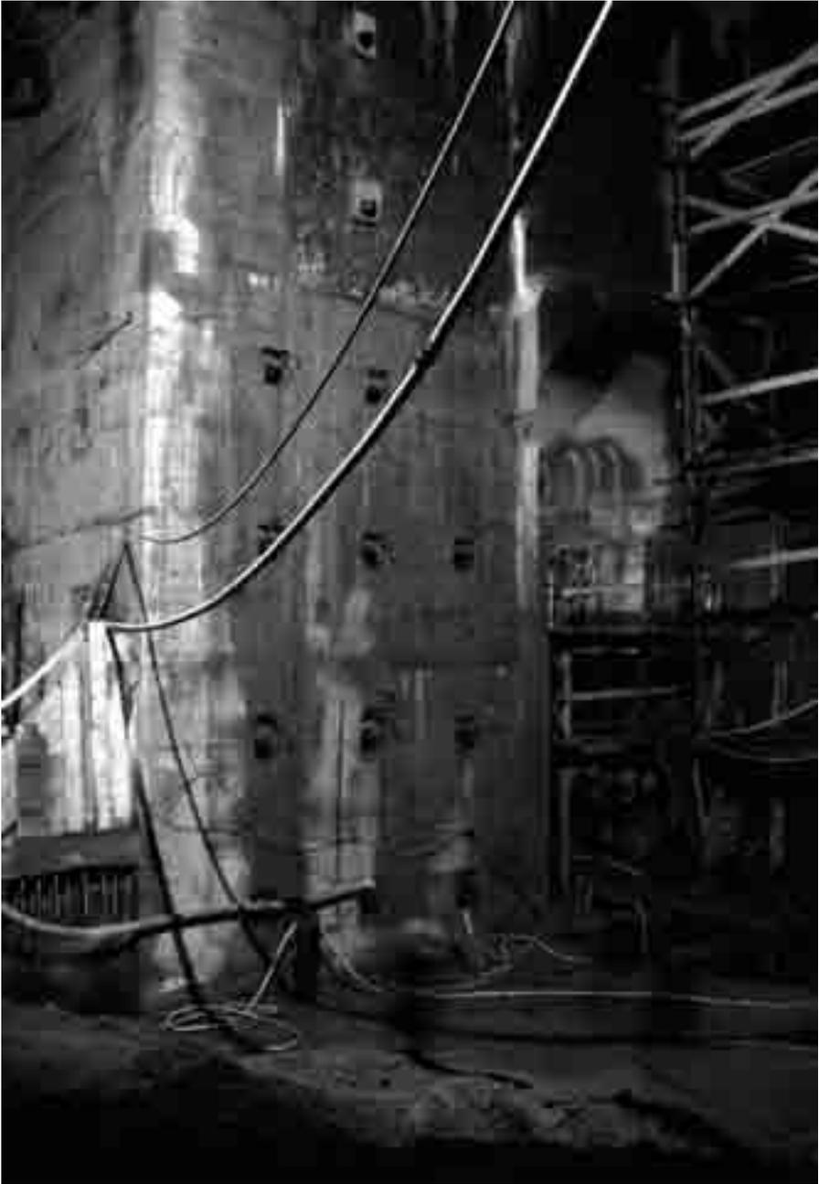
Abb. 20: Der angerissene Zentralpfeiler zwischen Reaktorkaverne und Stablager, nachdem er mit Ankern vorgespannt wurde (AKS, Nachlass Ribaux, 322.6).
