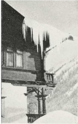
Eisbildung bei steilem Dach
