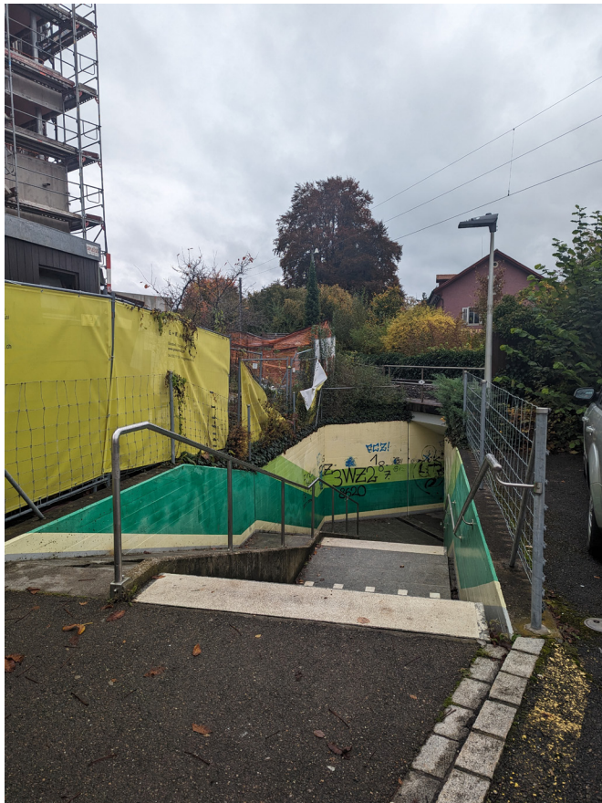
Abbildung 39: Bahngleisunterführung Talstrasse am 03.11.23
