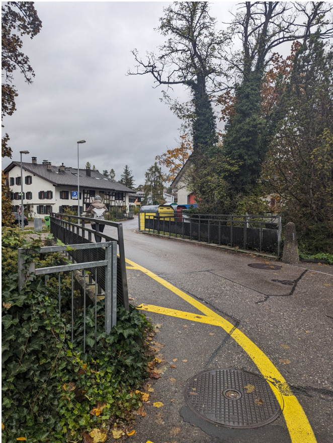
Abbildung 41: Brücke Kratzstrasse am 03.11.23
