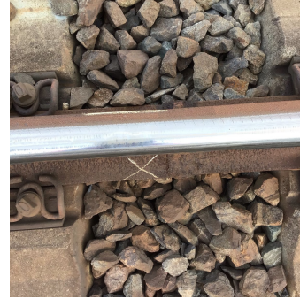
(d) Weld 6.1c after manual grinding
