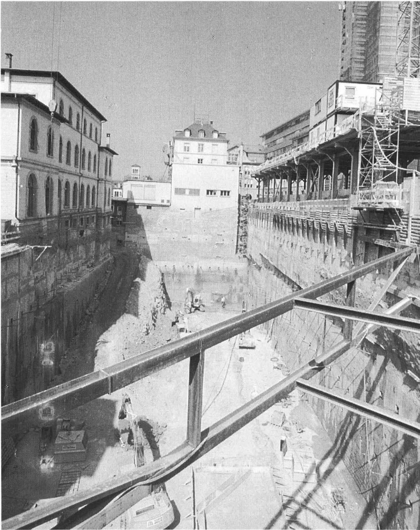
Aushubarbeiten für das neue Institutsgebäude an der Clausiusstrasse
