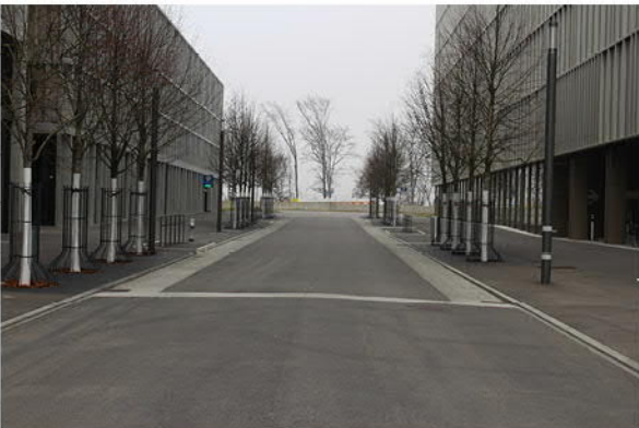
21. Gardistrasse, Blick in Richtung Aare
