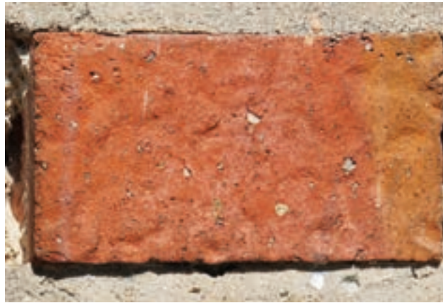
258 oben links Ansicht des Postamtes Südost in Berlin-Kreuzberg, 1925–1927. Der Stil des Gebäudes nimmt Anleihen am Backstein-expressionismus, es kamen jedoch keine vollformatigen Klinker zum Einsatz, stattdessen wurde ein sogenannter »aufgerauter Verblendstein« verwendet.
