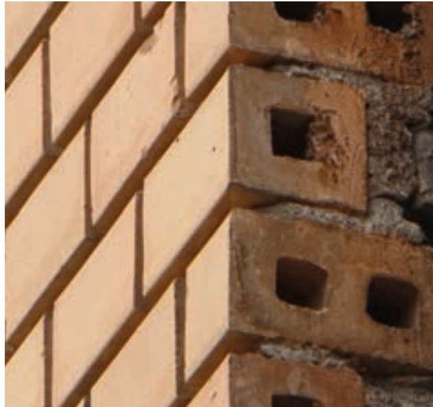
538 Langlochverblendfassade an der Zelgstrasse 4 in Zürich, 1896, mit einer der Zeichnung von Eckharts entsprechenden Fugenausbildung.
