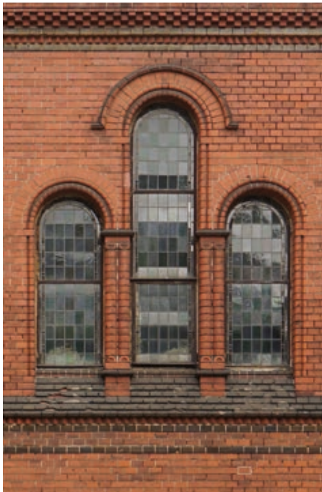
518 ► Das repräsentative Obergeschoss des Mittelrisalites am noch kurz vor Standardisierung der Verblendsteine errichteten Askanischen Gymnasium in Berlin, Blankenstein, 1874–1875, Verblendmaterial der Greppiner Werke. Das später so häufig wiederholte Formenrepertoire ist hier schon angelegt. Die Bögen bestehen aus keilförmigen Profilsteinen, von denen manche Schichten dekoriert sind. Im Bereich der Attika sind Konsolen eingesetzt.
