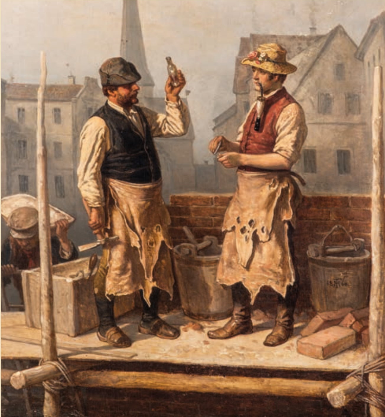
397 Die Kluft zwischen Theorie und Praxis: Theodor Hosemann: Maurer beim Bau des Roten Rathauses, Berlin, 1861. Es dürfte allerdings in der Realität nur wenige Wände gegeben haben, die tatsächlich im Läuferverband gemauert wurden, da Wandstärken unter 25 cm wenig verbreitet waren.
