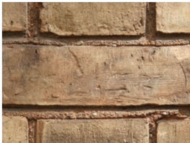
534 Mit der Fugenkelle geschnittene Fugen an der Bartholomäuskirche von Stüler in Berlin.
