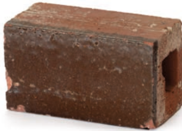
352 links \frac{1}{4} -Langlochverblander aus rotbraun brennendem Grundmaterial mit fast gleichfarbiger Engobe. Fundort Berlin Prenzlauer Berg.
