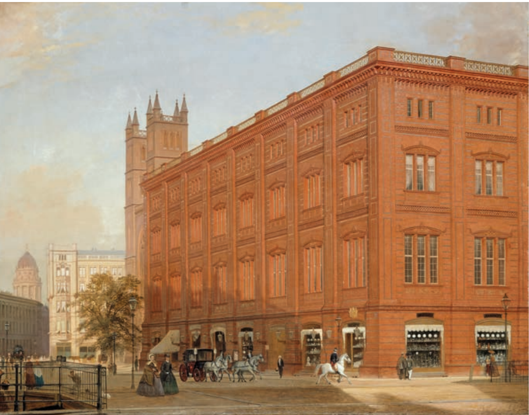
88 Die Bauakademie auf einem Gemälde von Eduard Gaertner, 1868. Im Hintergrund die Friedrich-Werdersche Kirche. Man beachte die tiefrote Darstellung des Verblendmaterials, durchsetzt von Betonungen aus glasierten Plättchen, die das Sonnenlicht reflektieren.
