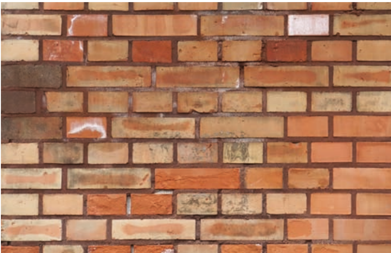
157 ◀ Die Kirche St. Thomas von Friedrich Adler (1864–1869), errichtet mit Verblendsteinen aus Hermsdorf, Kuppelfeilern aus Rathenower Ziegeln, Bögen aus Freienwalder Ziegeln und Gewölben und Kuppeln aus Greppiner Ziegeln.
