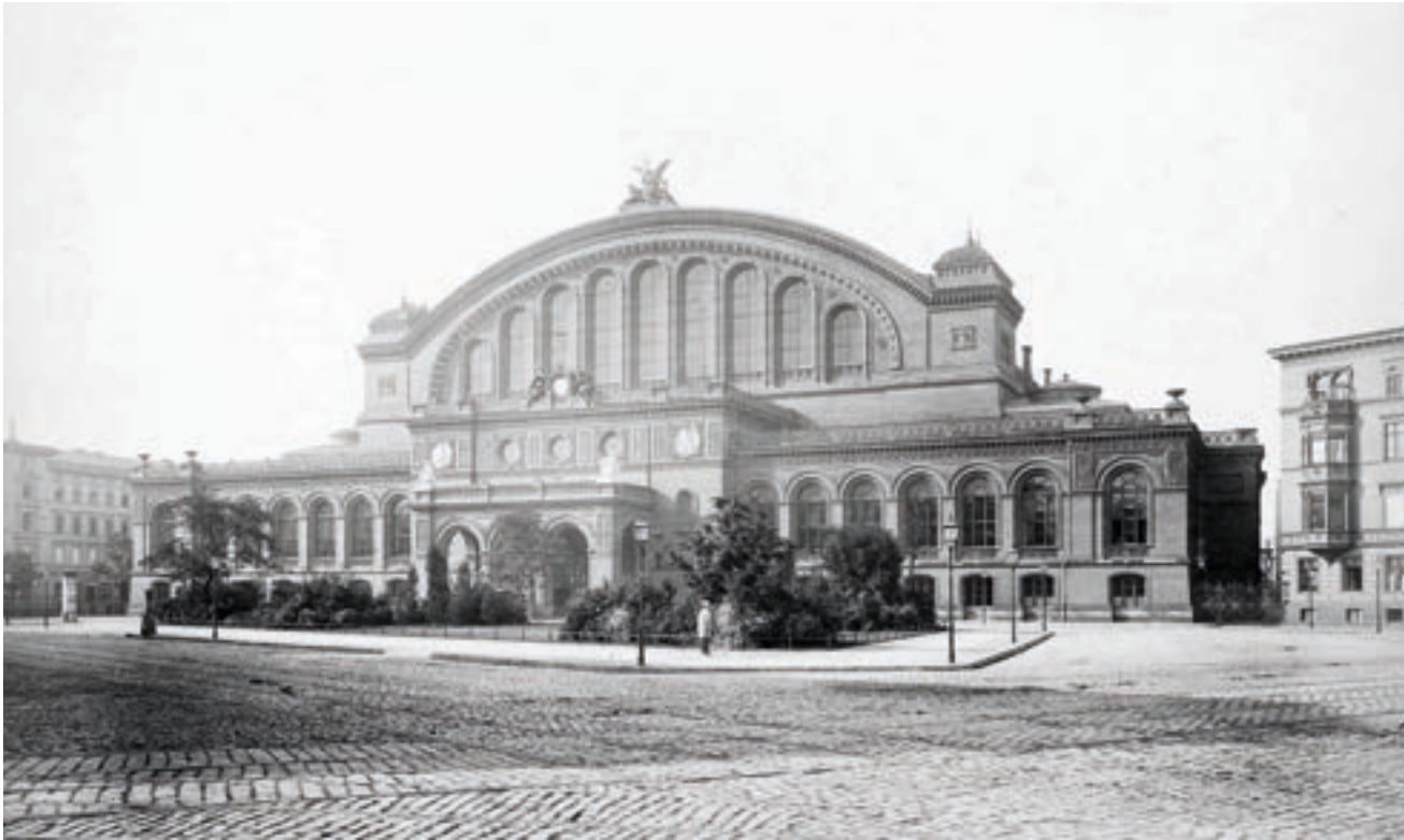
379 Auch Bahnhofsbauten waren nicht selten mit Sichtbackstein verblendet. Hier das Empfangsgebäude des Anhalter Bahnhofs am Askanischen Platz in Berlin, Franz Schwechten, 1876–1880, verblendet mit Steinen aus Bitterfeld, in einer Fotografie von 1881.
