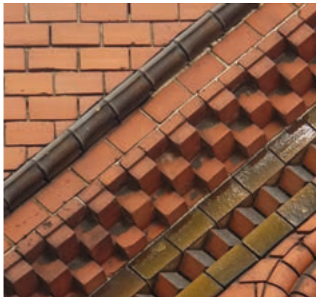
528 Kombination aus Deutschem Band aus glasierten Ziegeln und Schachbrettfries an der Friedhofskapelle Sophien II in Berlin, 1897.
