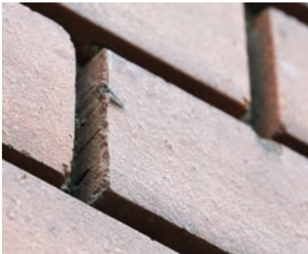
315 Die geschnittene Stoßfläche eines Langlochverblanders am Hirschengraben 48, Zürich, 1891.
