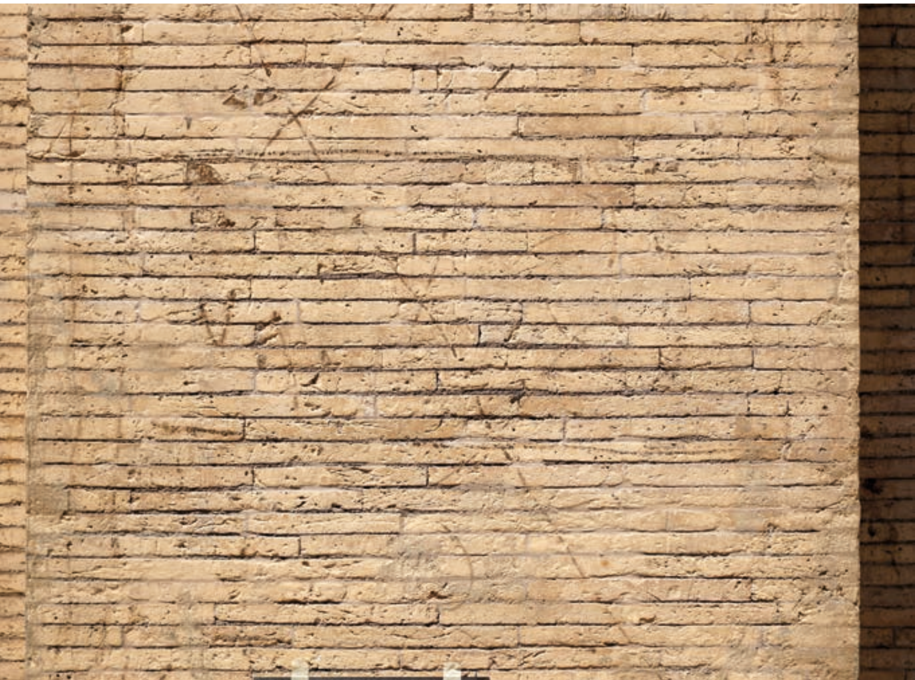
46 oben Ansicht des Sichtmauerwerks im Erdgeschoss an einem der Pilaster des Oratorio dei Filippini.
