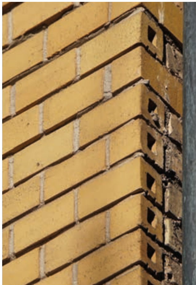
405 rechts Sparversion einer Langlochverblendfassade: Die Hintermauerung aus Backstein ist nur wenig mit der hauptsächlich aus \frac{1}{4} -Steinen bestehenden Verblendschicht verzahnt. Zürich, Rieterstrasse 89, 1899.
