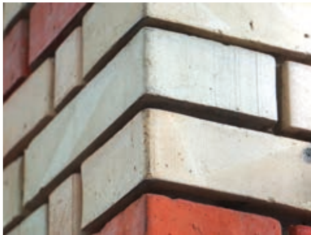
301 links Sichtbare Abrundung und Strangspuren an einem Stein in Ecksituation an der Fassade des ehemaligen Chemiegebäudes des Polytechnikums Zürich, 1884–1886.
