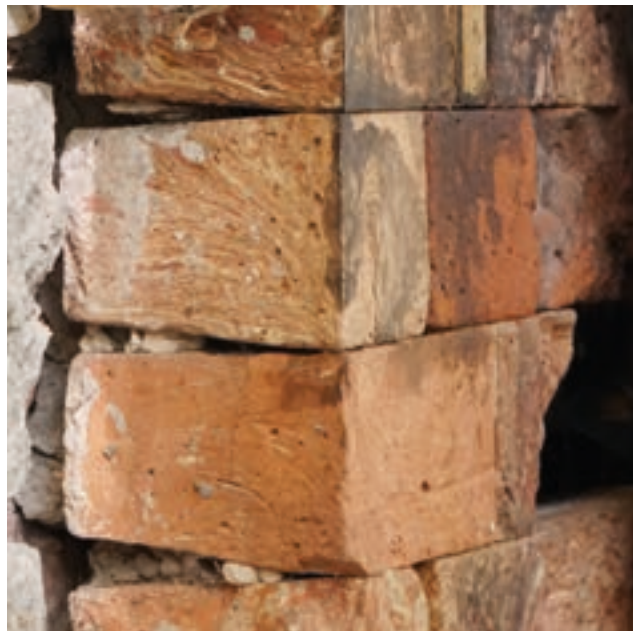
546 links Fugenbreiten der vermessenen Objekte in München in mm, aufgeteilt in Lager- und Stoßfuge.
