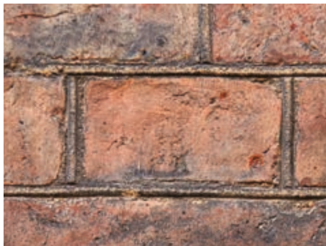
535 Mit dem Fugeisen hergestellte Rundstabfugen an der Friedrich-Werderschen Kirche von Schinkel in Berlin.
