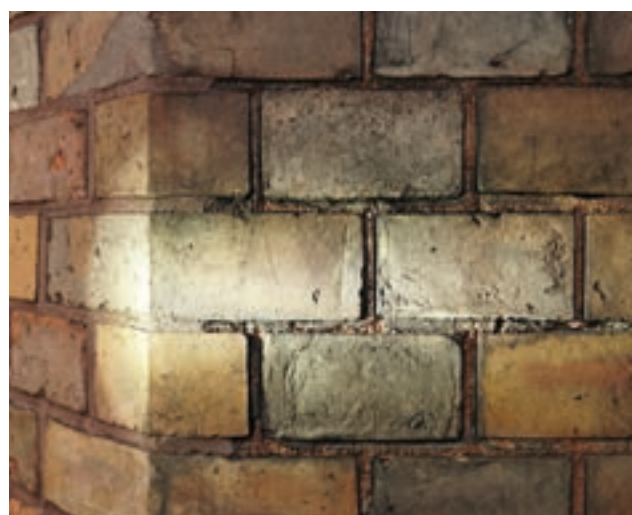
481 Detail des oben rechts abgebildeten oktogonalen Pfeilers der Bartholomäuskirche. Wie die Beleuchtung mit Streiflicht zeigt, setzen sich die 135°-Ecksteine durch ihre glattere Oberfläche deutlich vom normalen Ölstein-Verblendmaterial ab.
