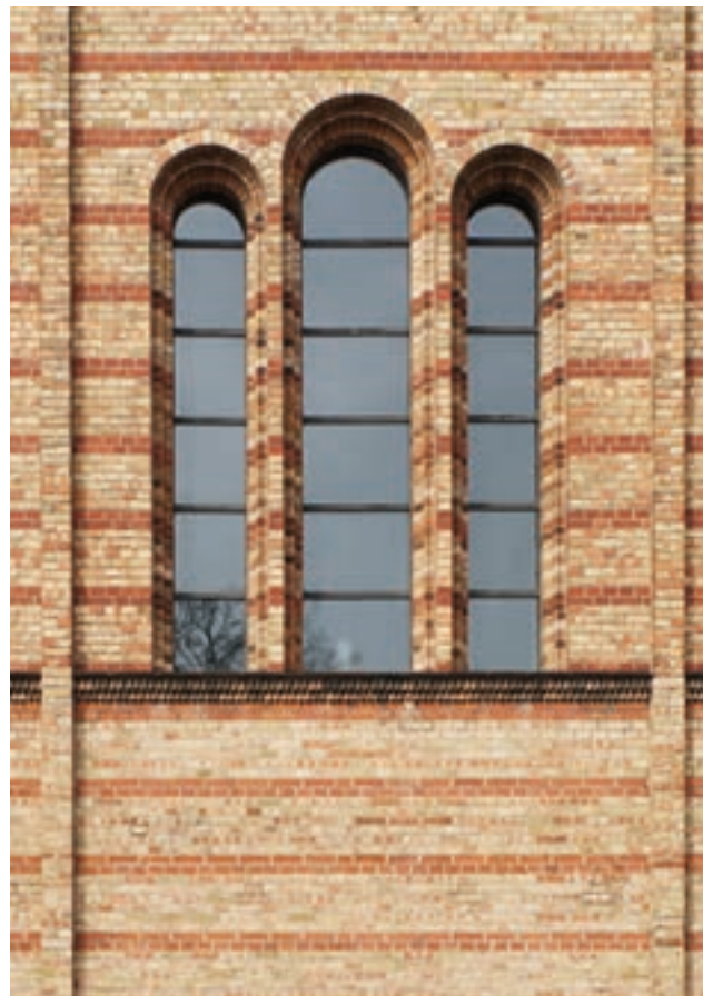
522 Fassadenausschnitt der Matthäuskirche von Stüler. Die Fassade ist sowohl durch polychrome Akzente, wie die roten Bänder, als auch plastische Zierelemente, wie das Gesims unterhalb der oberen Fensterzone oder im Bereich des Dachrandes gegliedert.
