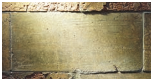
288 Polierspuren an einem Stein der Fassade der Frauengebäranstalt, München, 1853–1856.
