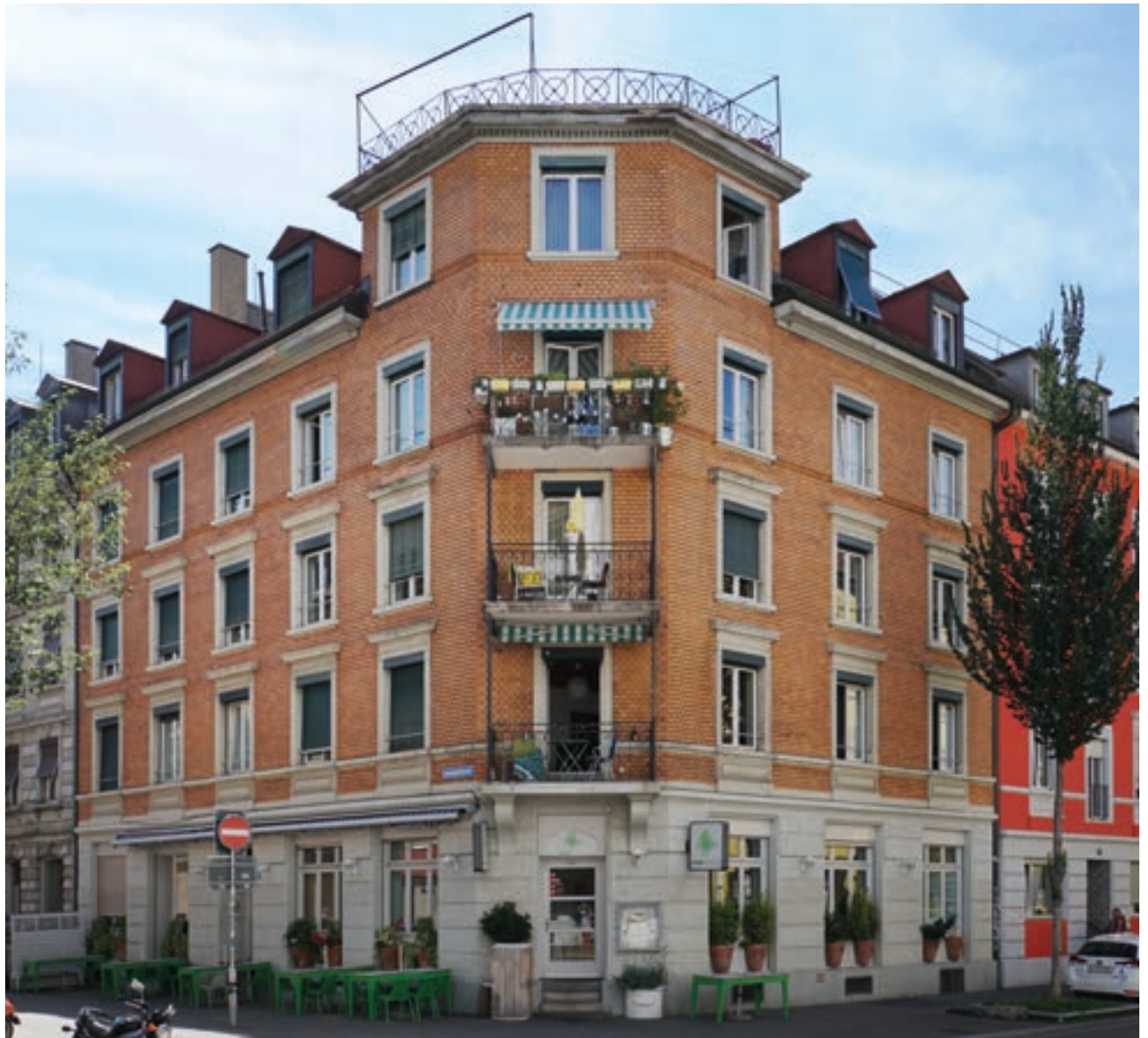
488 135°-Ecken kamen gerade bei Blockranddecken häufig vor. An diesem Gebäude aus dem Jahr 1895 an der Luisenstrasse/Ecke Heinrichstrasse in Zürich wurde die Ecke durch die Überhöhung noch besonders betont.
