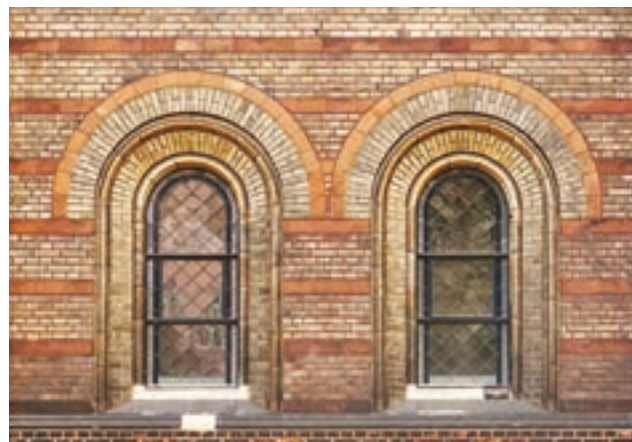
524 Ansicht der Zionskirche in Berlin, 1866–1872. Das gelbe Verblendmaterial aus Vollverblendern ist durch horizontale Streifen aus braunen Platten gegliedert, die auch den Bogen oberhalb des Fensters abschließen.
