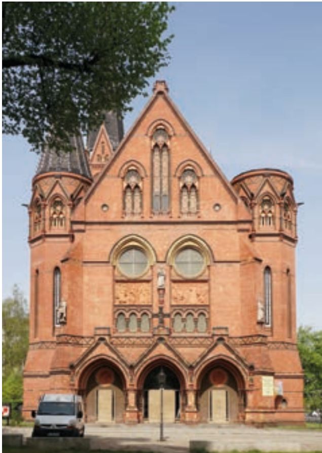
245 unten rechts Verblendmauerwerk der Lutherkirche. Otzen setzte, anders als Hase, nicht auf vollformatige Ziegel, sondern konnte sich mit Langlochverblendern arrangieren.
