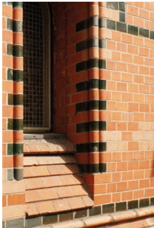
500 Fenster an der Lutherkirche in Berlin von Johannes Otzen, 1891–1894, eingefasst mit Rundstab-Profilziegeln und einer Sohlbank aus Schrägsteinen.
