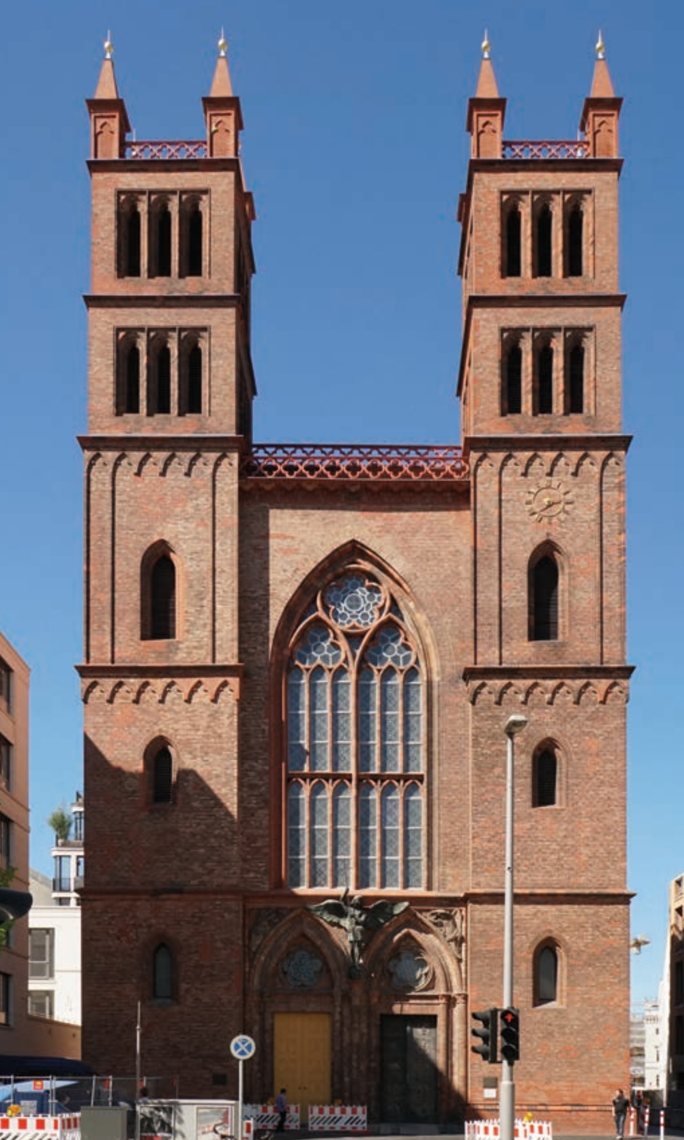
99 Frontfassade der Friedrich-Werderschen Kirche, Schinkels erster repräsentativer Sichtbacksteinbau, erbaut ab 1824.
