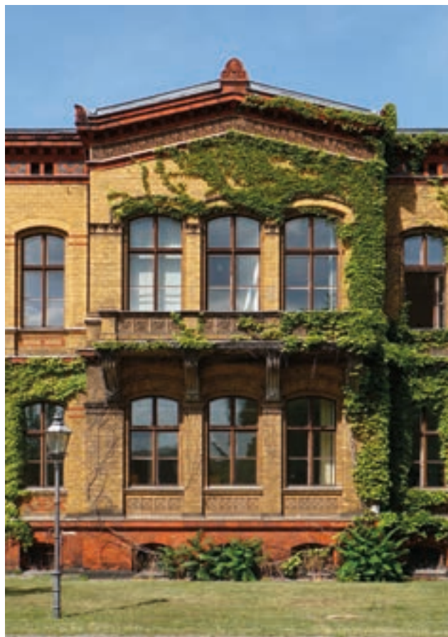
398 Eine für das Berlin unter Blankenstein typische Ausführung des Backstein-Rohbaus: gelber Verblender über einem roten Sockel. Hospital und Siechenhaus an der Prenzlauer Allee, Blankenstein, 1886–1889.
