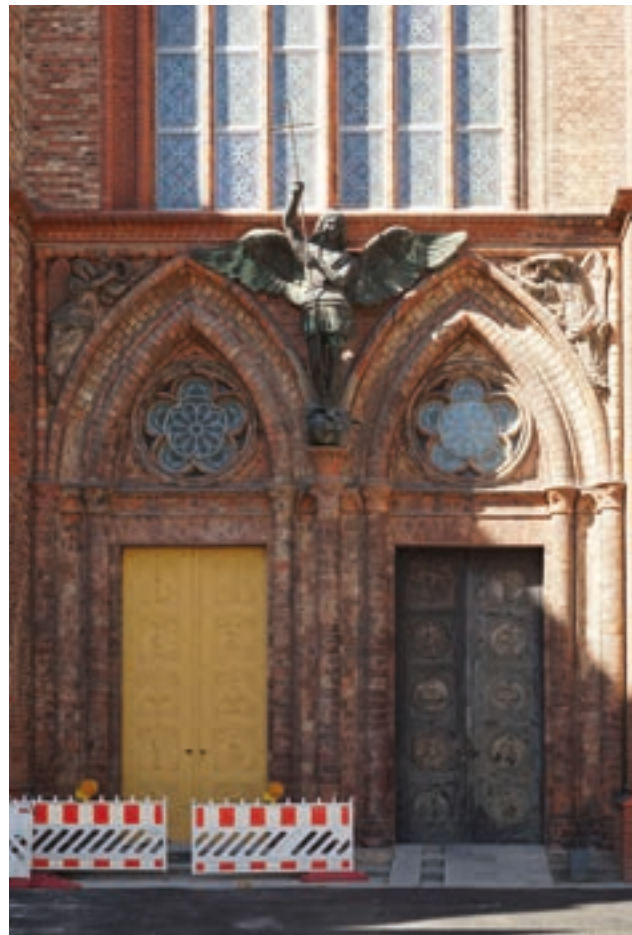
503 Portal der Friedrich-Werderschen Kirche. Die normalen Formsteine stammten, wie auch das gewöhnliche Verblendmaterial, aus Joachimsthal, die komplizierten Formstücke sowie den Erzengel Gabriel schuf Feilner. Die kupferne Replika des nicht mehr vorhandenen Originalengels aus Ton wurde 1914 angebracht.
