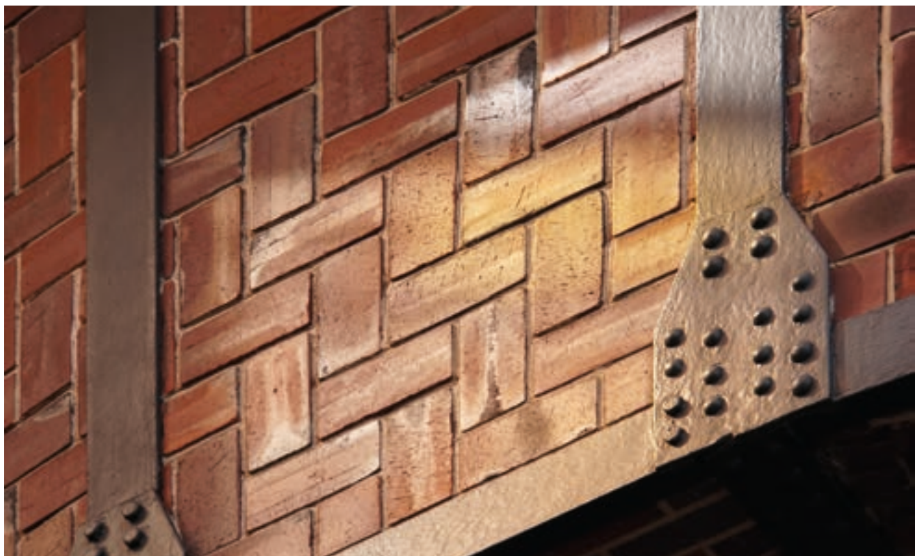
257 unten Klinker als Ausfächung der Stahlstruktur am Abspannwerk Buchhändlerhof. Der ornamentale Verband aus flachkant vermauerten Ziegeln zeigt, dass das Sichtmauerwerk keine Tragwirkung übernimmt, was den Anspruch an eine »ehrliche« Konstruktion unterstreicht. Im Streiflicht sieht man auf den nach außen zeigenden, eigentlich als Lagerflächen gedachten Seiten teilweise recht deutlich Spuren des radialen Abschnittes des Stranges.
