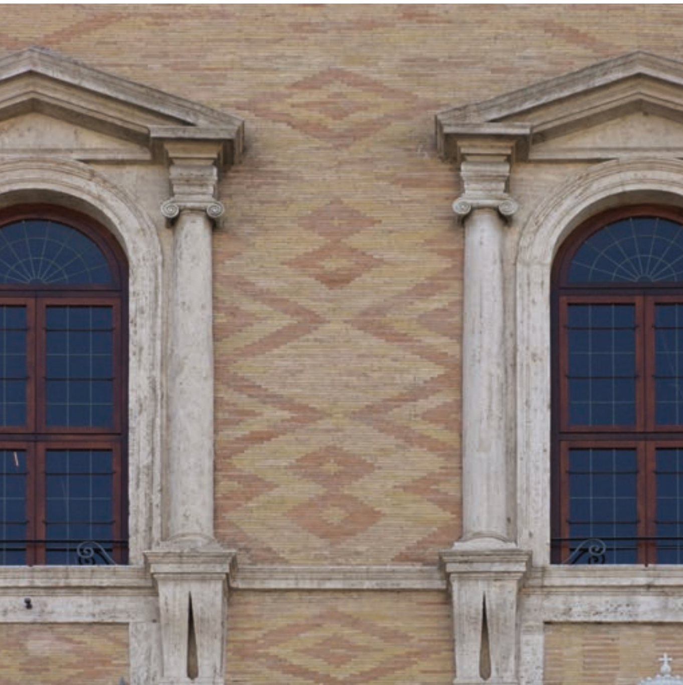
44 Detail des polychromen Backsteinmauerwerks im Obergeschoss des Palazzo Farnese.
