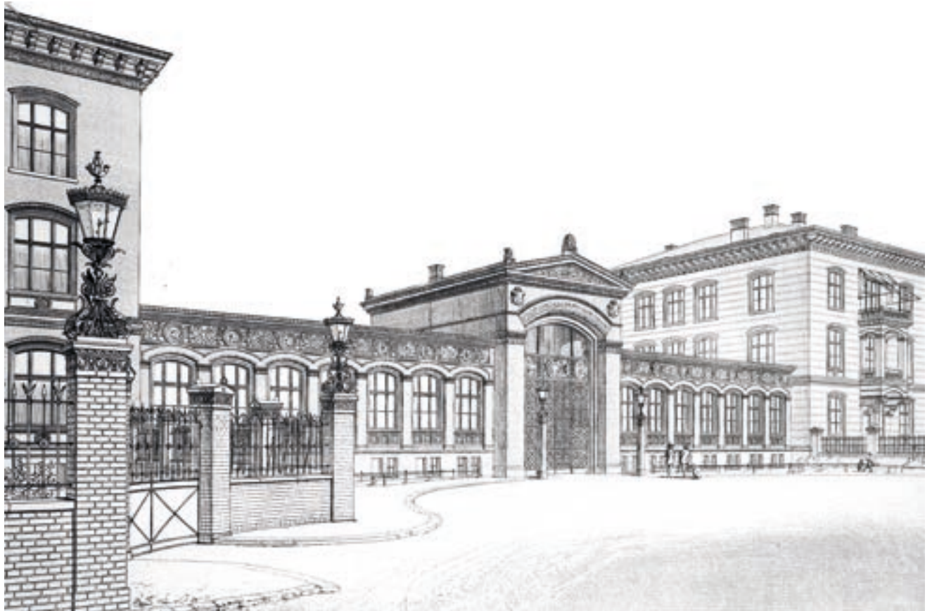
199 oben Das Krankenhaus am Friedrichshain der Sozietät Gropius & Schmieden, 1870–1874. Als Verblendmaterial wurde aus Kostengründen auf rot engobierte Ziegel der Greppiner Werke zurückgegriffen, nur für das Verwaltungsgebäude leistete man sich Laubaner Steine.
