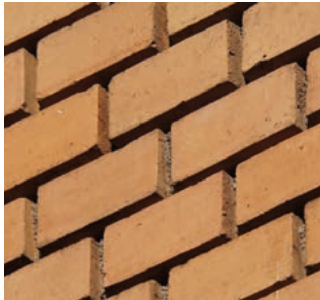
539 Langlochverblendfassade mit weit zurückliegenden Fugen, was eine lebhaftere Wirkung hervorrufen sollte. Zürich, Luisenstrasse 95, 1895.
