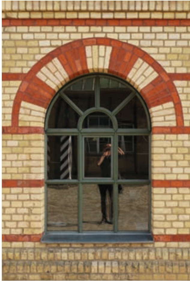
498 Im Verband gemauertes Fenster mit Laibungen aus quaderförmigen Backsteinen am Zeughaus der Zitadelle Spandau, 1856–1857. Der ebenfalls in Backstein ausgeführte Bogen über dem Fenster ist aus keilförmigen Ziegeln gemauert.
