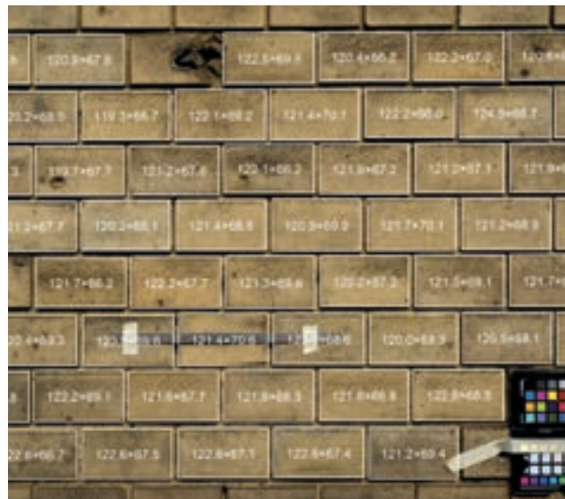
416 Boxplots der Maße des rechts abgebildeten Fassadenausschnitts des Naturkundemuseums. Die nur als Binder vermauerten 1/2- und 1/4-Langlochverblender orientieren sich offensichtlich am Verblendsteinmaß.
