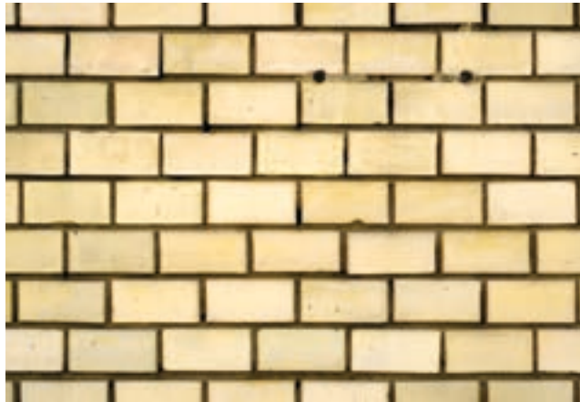
456 Binderverband aus vertikal gepressten Maschinensteinen an einem Gebäude in der Weberstrasse in Zürich, 1908.
