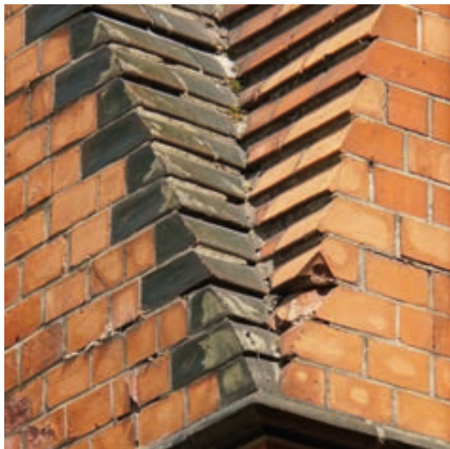
513 links Die nicht offiziell normierten Schrägsteine mit Tropfnase an der Lutherkirche in Berlin, 1891-1894, von Johannes Otzen.
