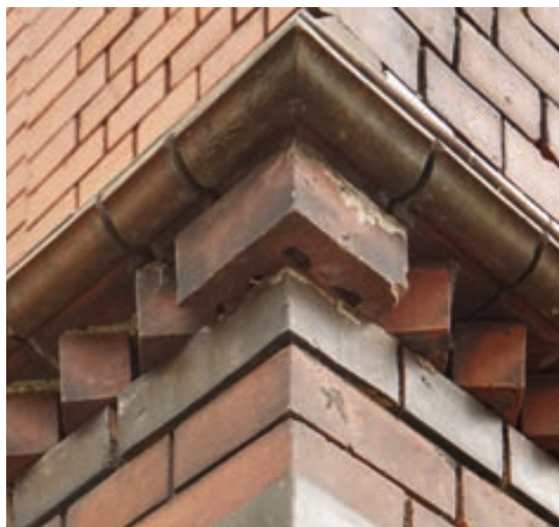
529 An der Ecke zeigt sich, dass die Zierbänder der Kapelle des Friedhofs Sophien II unter anderem aus vertikal gelochten Eckziegeln bestehen.
