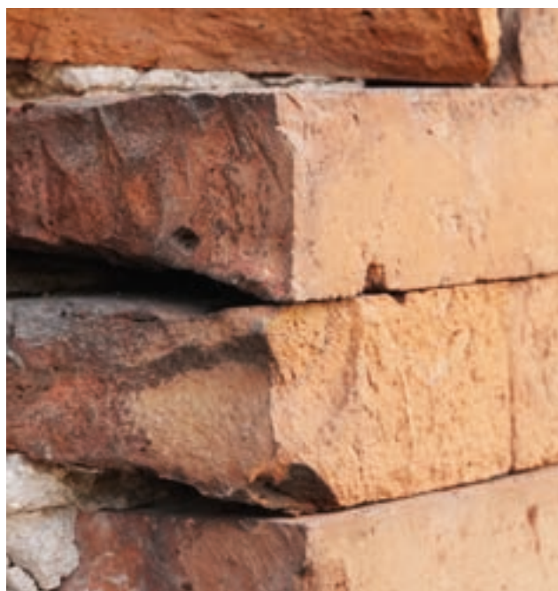
291 Keilstein an der Salinenadministration, München, 1838–1843. Sichtbar der direkt an die Sichtfläche anschließende orthogonale Zuschnitt sowie die freihändig erfolgte Ausbildung der Keilform.
