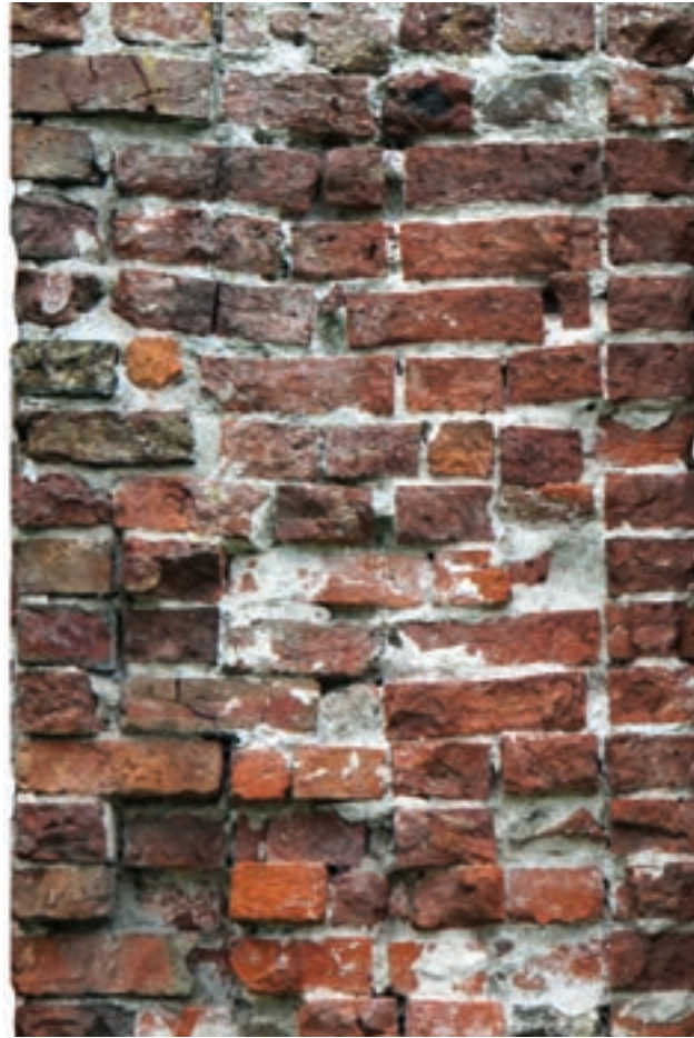
30 oben links Wandaufbau aus Ziegelschalen mit Bruchsteinfüllung. Reste der Ambrosiuskapelle der Kirche San Domenico in Siena, 13. Jh.
