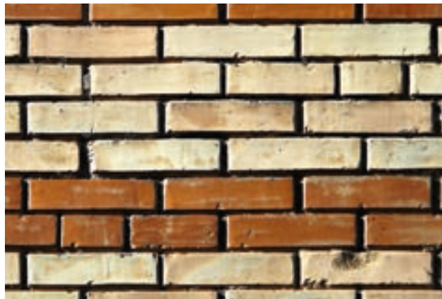
459 Verblendschale im Läuferverband. Die einzelnen für die Rückbindung der Verkleidung benötigten Binder heben sich deutlich vom Rest der Mauer ab. Zürich, Konradstrasse 6, 1881.
