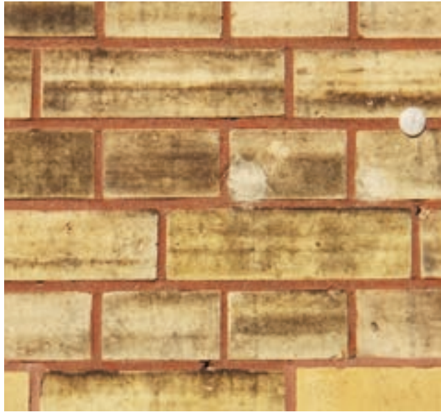
541 Eine in Berlin verbreitete Farbkombination: gelbe Verblendung mit glatten, roten Fugen, Neue Synagoge, Berlin, Knoblauch, 1859–1866.
