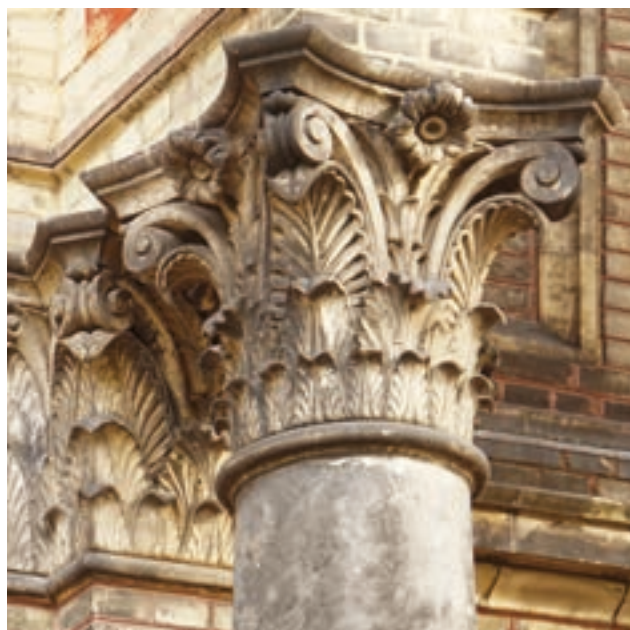
508 Nicht ganz klassischen Formen folgendes korinthisches Terrakottakapitell an der Zionskirche in Berlin. Die Terrakotten der 1866–1872 von August Orth erbauten Kirche stammten von March.
