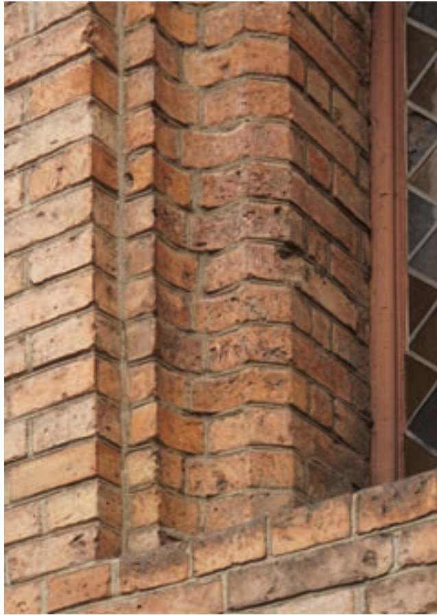
505 Formsteinlaibung an der Nazarethkirche im Wedding. Die Profilsteine wurden erst nachträglich aus dem als Quader geformten Ziegel gearbeitet, wie man an einem Vergleich der Profilflächen mit den deutlich glatteren Seitenflächen sieht.
