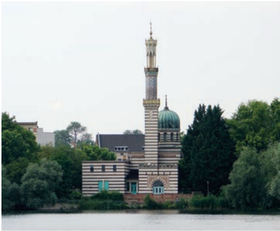
107 links Das Dampfmaschinenhaus für den Betrieb der Fontänen in Sanssouci, Ludwig Persius, 1841–1843.
