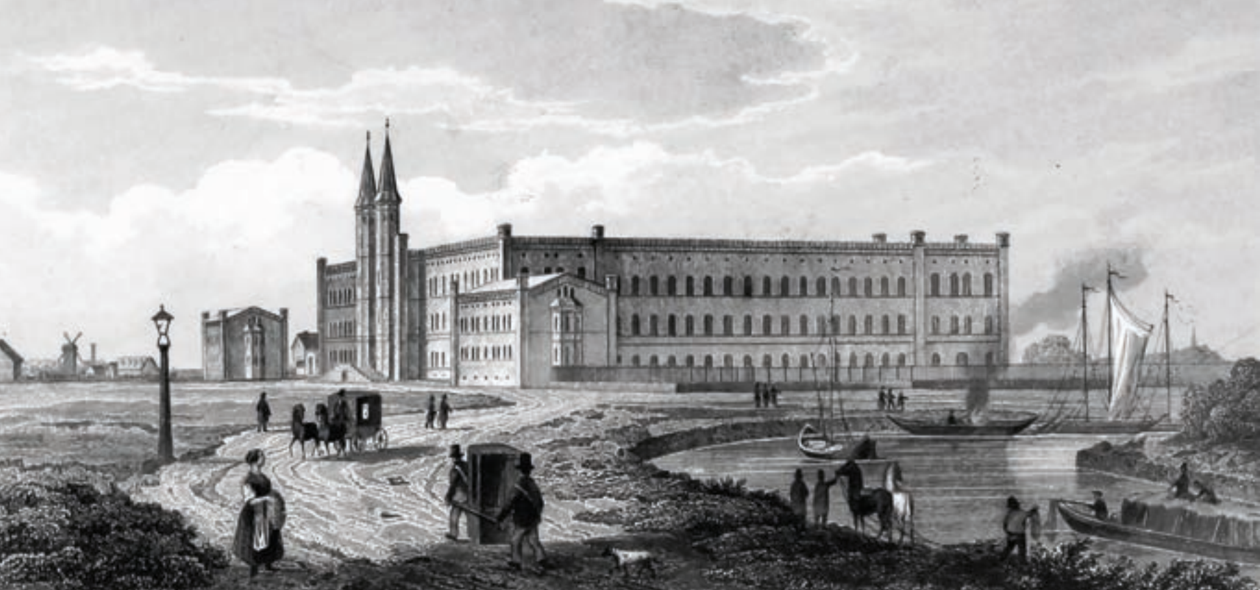
124 oben Das Diakonissenkrankenhaus Bethanien, Ludwig Persius und Theodor August Stein, 1845–1847: Darstellung in seiner ursprünglichen, freistehenden Lage. Im Vordergrund die Kurve des Luisenstädtischen Kanal.
