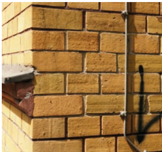
486 Im Streiflicht wird sichtbar, dass die Verblender in der Fläche horizontal, die Ecksteine aber vertikal gepresst wurden. Ansicht einer Ecksituation an der 133. und 149. Gemeindedoppelschule in Berlin-Kreuzberg.
