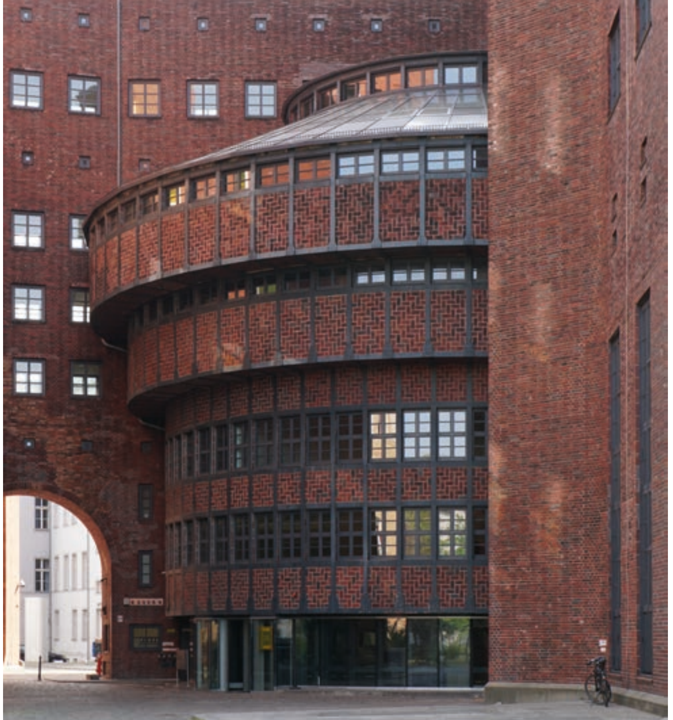
256 oben Klinkerrohbau in Berlin: das Abspannwerk Buchhändlerhof, Hans Heinrich Müller, 1927–1928.
