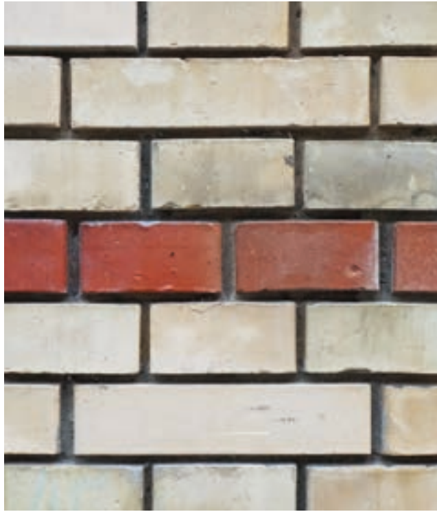
300 rechts Gleicher Ausschnitt wie links unter Streiflicht. Gut sichtbar das Strangprofil sowie der ausgetauschte Läufer mit anderer Oberflächenstruktur.
