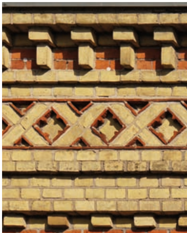
530 ◀ Ornamentaler Verband aus Verblendsteinen und Dachziegeln, wie er für den Backstein-Rohbau des 19. Jahrhunderts typisch war, in Zürich aber selten ausgeführt wurde. Zürich, Rote Fabrik, 1892.
