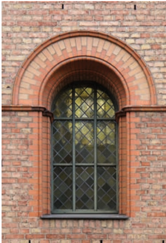
506 Fenster der Johanniskirche in Moabit mit klar vom eigentlichen Verblendmaterial abgesetzten Formziegeln im heutigen Zustand.
