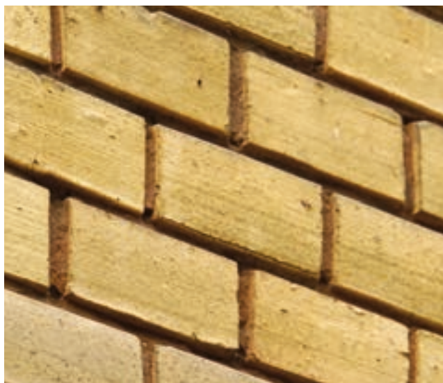
304 rechts Langlochverblander an der Bolleystrasse 3–7, Zürich, 1896. Die scharfen Kanten und horizontalen Ausreißungen an den Oberflächen lassen vermuten, dass die Steine mit einem Mundstück mit vorgespannten Drähten produziert wurden.
