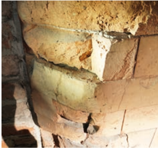
482 Einblick in die Konstruktion der oktagonalen Pilaster am Münchener Südfriedhof. Man erkennt den etwa 1–1,5 cm breiten Streifen des orthogonalen Anschnittes, dahinter den Ansatz der freihändig zugeschnittenen Keilform.
