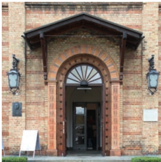
507 Portal der Matthäuskirche in Berlin. Die bauzeitlichen Terrakotten stammen von March. Die Kirche wurde nach Kriegsschäden stark restauriert.
