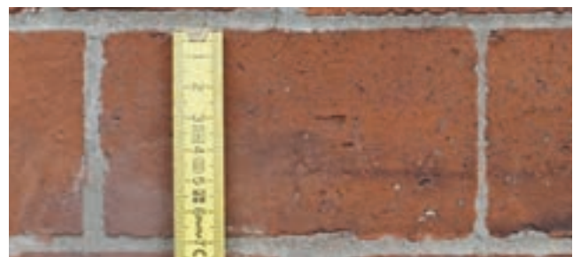
249 rechts unten Das Format der Ziegel an der Christuskirche folgte dem von Otzen propagierten und für Langlochverblender entwickelten Verblendziegelformat. Der abgebildete Stein ist genau 69 mm hoch. Auch in der Breite stimmen die Verblender mit dem standardisierten Verblendsteinmaß überein, der abgebildete Binder ist genau 122 mm lang.
