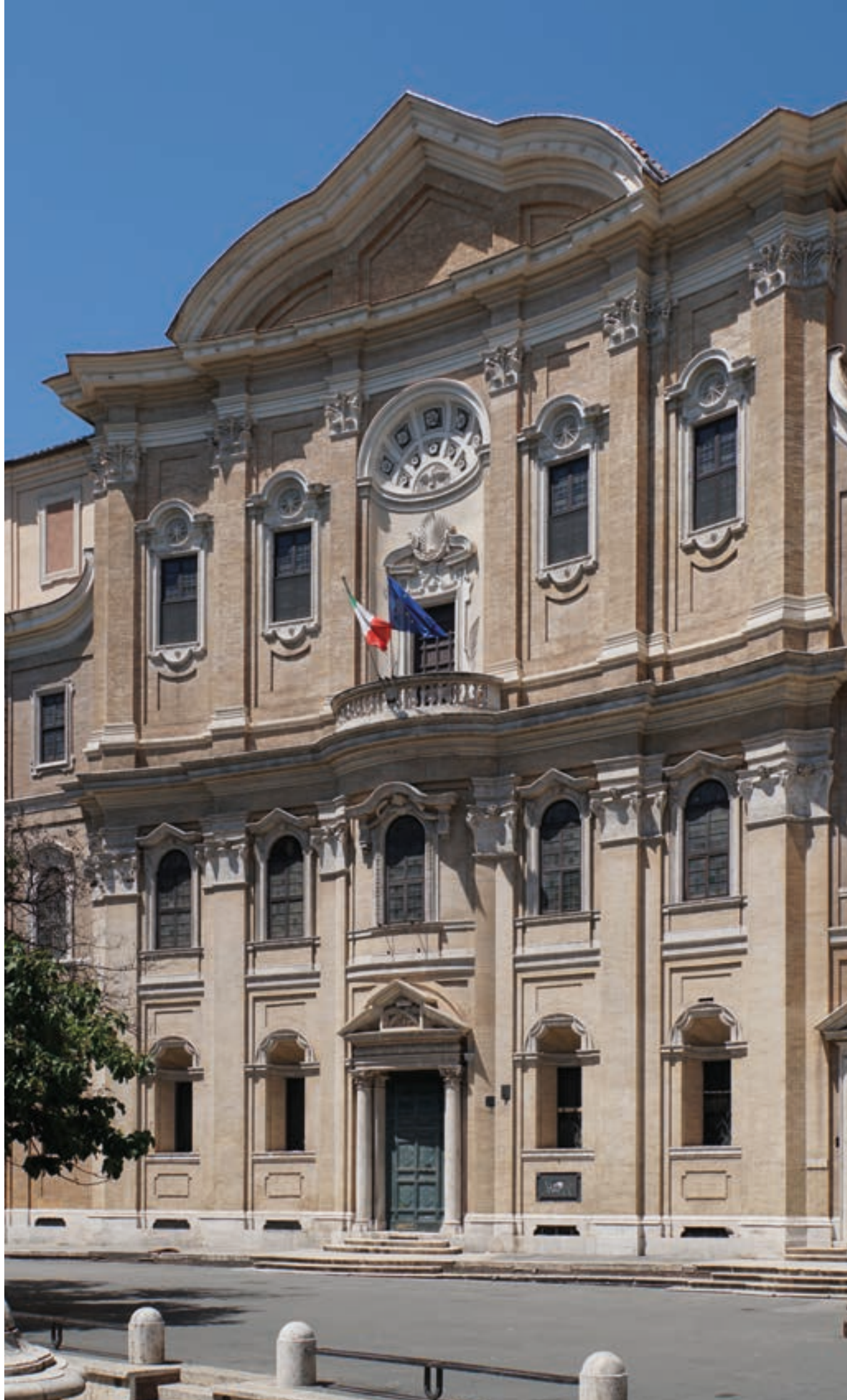
45 Ansicht der ziegelsichtigen Hauptfassade des Oratorio dei Filippini, erbaut von Francesco Borromini um die Mitte des 17. Jhs.
