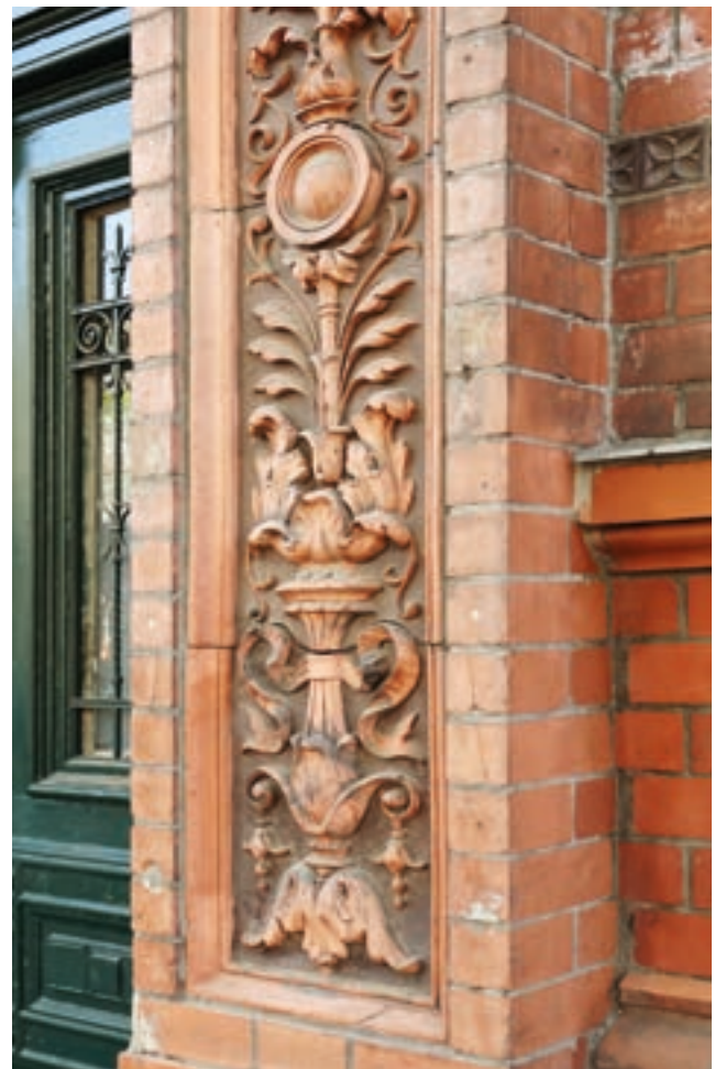
520 links Mit flachen Relieferrakotten gerahmter Eingang der 115. und 237. Gemeindegchule in Berlin, Blankenstein, 1886–1887.
