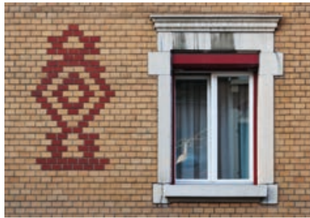
494 Fenstereinfassung in Werkstein bei einer LangloCHFassade: sechsteiliges eigentliches Fenstergestell, ergänzt um ein profiliertes Abdeckgesims an der Zentralstrasse 63–69 in Zürich, 1894. Der auf Biegung belastete Sturz wurde stärker als die Gewände ausgeführt.
