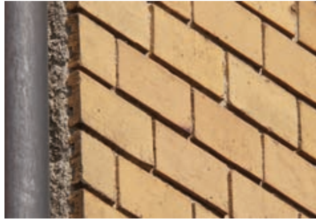
469 links Langlochverblender im gegen Ende des Jahrhunderts weitverbreiteten Binderverband an einem Gebäude in der Weberstrasse 21 in Zürich, 1895.
