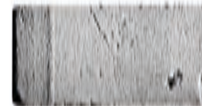
161 unten Binder unter starkem Streiflicht: vertikales Relief und beschnittene Kanten.
