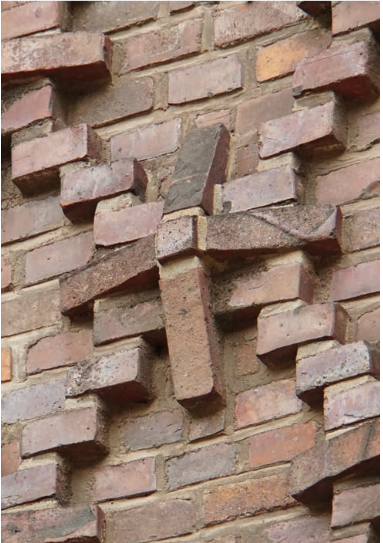
254 Ein ornamentaler, dreidimensionaler Zierverband am Chilehaus. Auf vielen Läufern kann man deutlich die Eindrücke der beim Brand angrenzenden Schichten erkennen.
