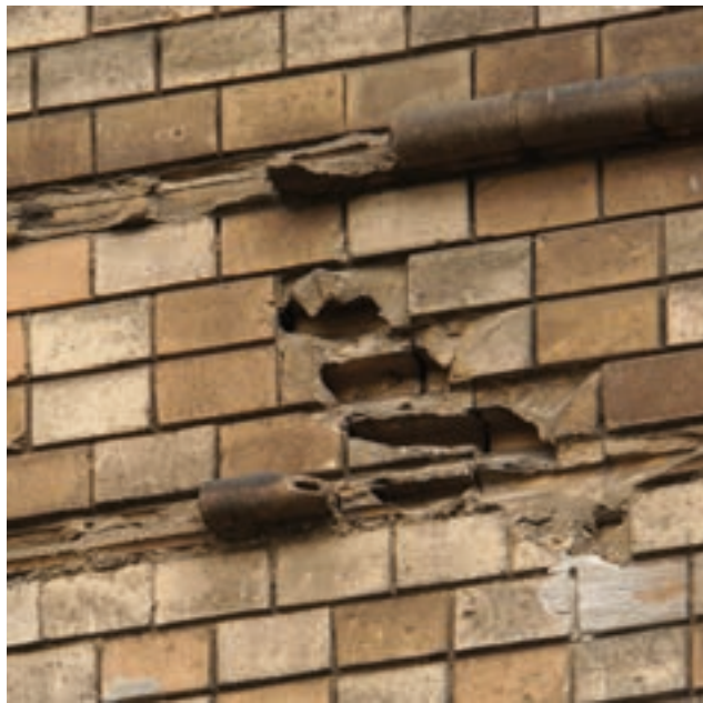
512 rechts \frac{3}{4} - und \frac{1}{2} -Formsteine mit Rundstab am Postfuhramt in Berlin. Links im Licht sichtbar die im Gegensatz zu den Formsteinen horizontale Ausrichtung der Pressspuren der Langlochverblender.
