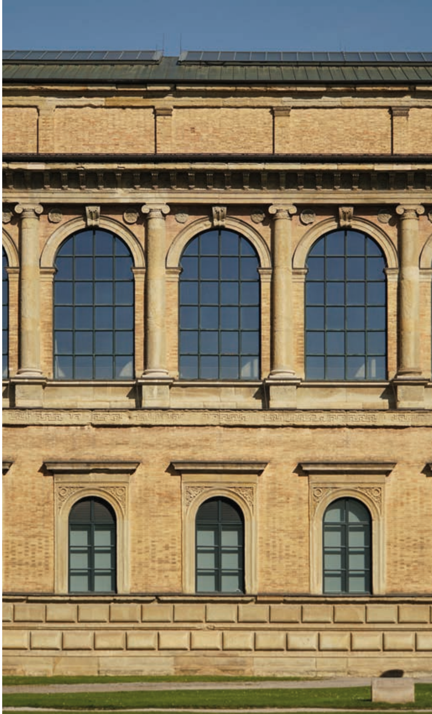
59 Fassadengliederung der Südseite der Pinakothek mit großzügigen Flächen in gelblichem Sichtbackstein.
