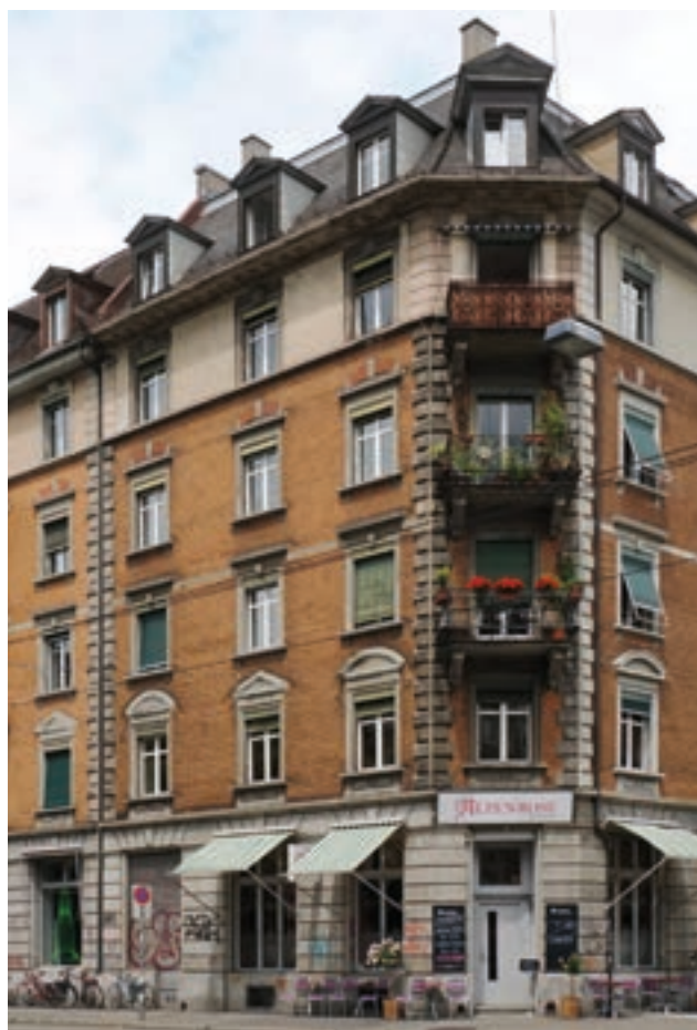
399 In Zürich verbreitete Ausführung: Der Backstein-Rohbau beginnt erst über einem Sockel aus Putz oder Werkstein. Fabrikstrasse/ Ecke Limmatstrasse, 1896–1897.
