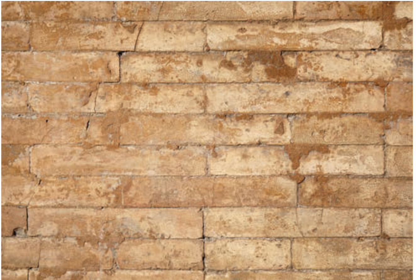
51 oben rechts Übergang vom feinen Fassadenmauerwerk zum gewöhnlichen Mauerwerk an den Seiten des Mittelrisalites des Palazzo Ducale in Modena.
