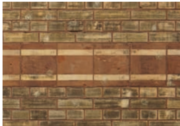
523 Detail des Verblendmauerwerks an der Neuen Synagoge in Berlin, 1859–1866. Die im Kreuzverband ausgeführte Verblendung ist durch horizontale Bänder aus braunen Platten gegliedert.
