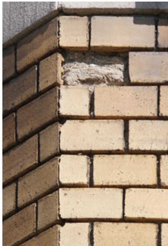
493 Ausbildung einer 135°-Ecke mit auf Gehrung geschnittenen Plättchen an der Zentralstrasse 72-78 in Zürich, 1911.
