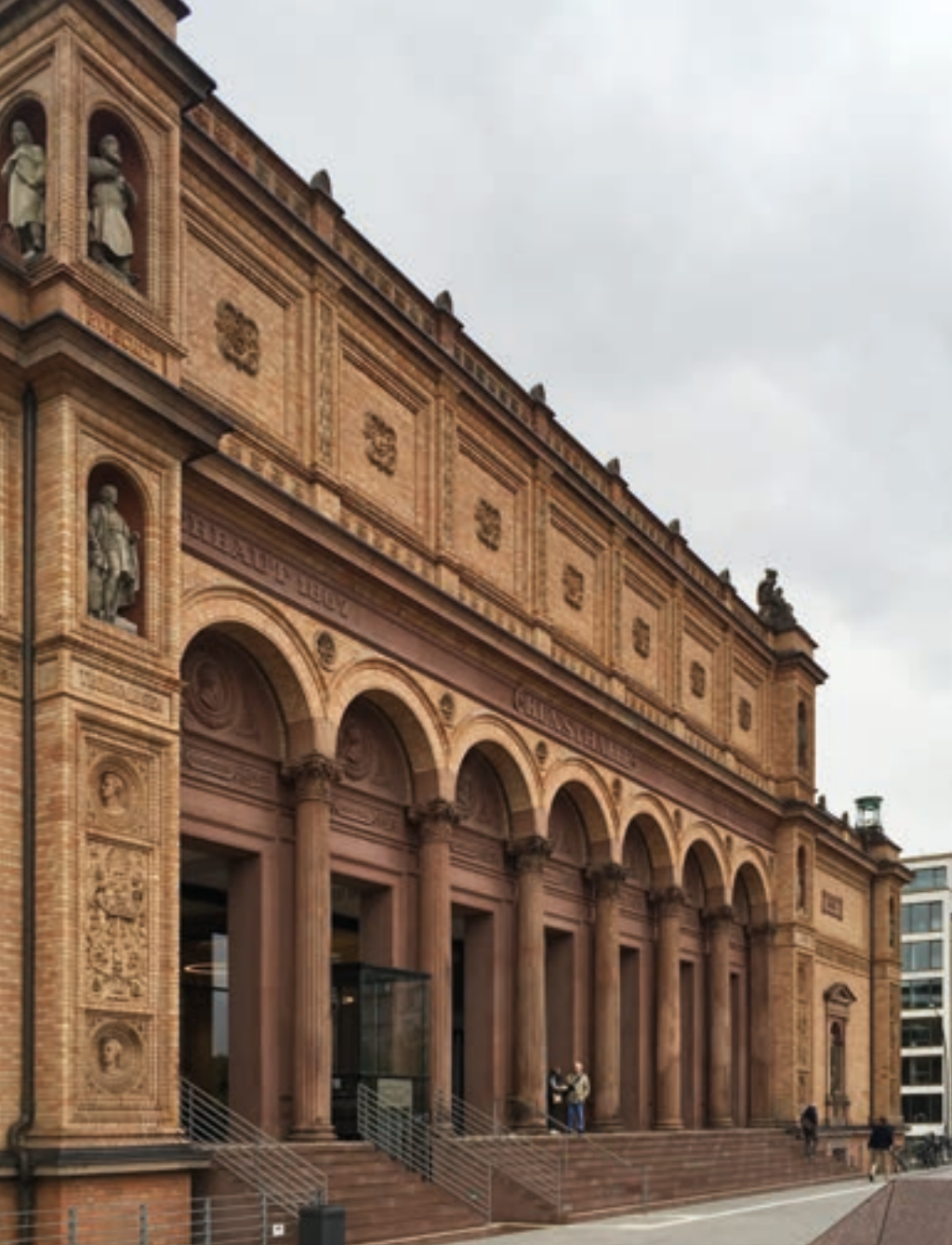
248 links Ein Berliner Backstein-Rohbau in Hamburg: die Kunsthalle, Hermann von der Hude und Georg Theodor Schirmacher, 1863–1866. Das Gebäude folgt nicht nur der Formsprache der Berliner »Terrakottenbauten«, es wurde auch ganz konkret mit Verblendziegeln der brandenburgischen Hermsdorfer Ziegelei von Lessing verkleidet.
