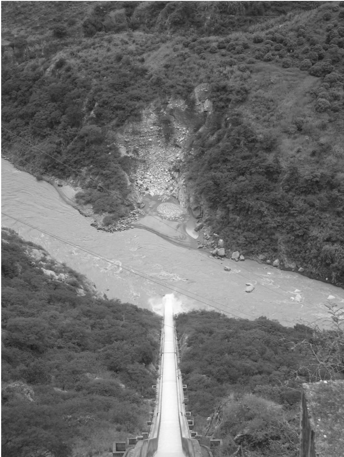
Bild 1-2: Schussrinne Restitucion, Peru; Erosionsschaden am gegenüber liegenden Ufer (Photo Mouvet, Stucky SA).
