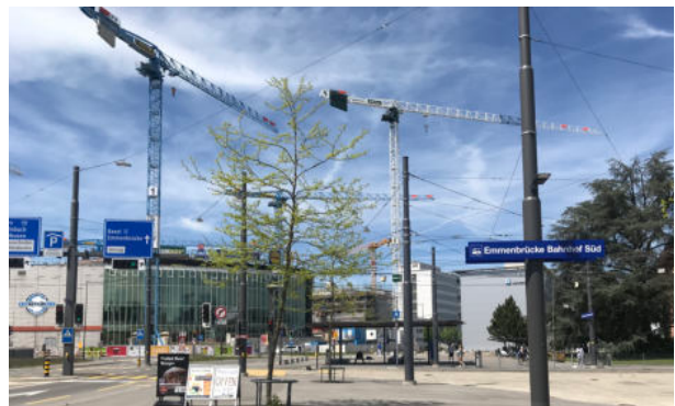
Abb. 8: Seetalplatz Emmenbrücke (eigenes Foto, 2021).
