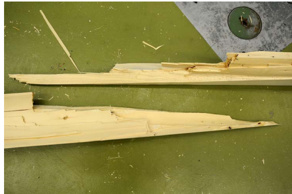
(d) lowest and 2nd lowest lamella ( l \approx 4.8 - 5.8 m)
