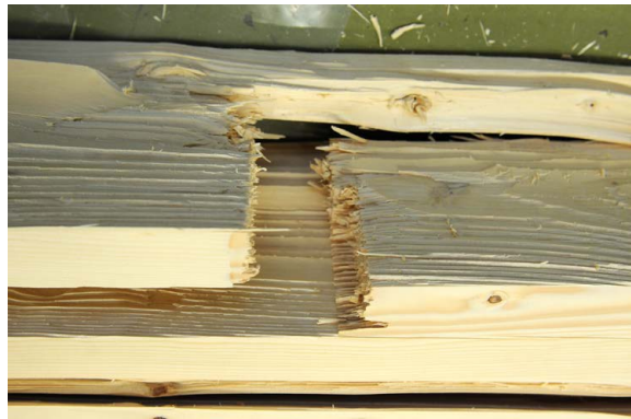
(d) 6th lowest lamella ( l \approx 8.0 m), back side
