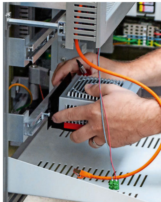
6 | Einbau des Industrie-PCs in den Steuergeräteschrank.
