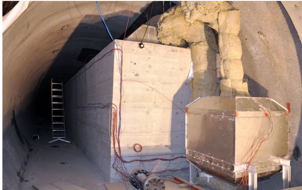
Abbildung 4: Sensibel-latenter thermischer Speicher in der Pilotanlage bei Biasca. Links: der mit Kieselsteinen gefüllte sensible Speicher (3,1 m hoch, 9,9 m lang und 2,4 m breit). Rechts: der latente Speicher (etwa 1,5 m hoch, lang und breit).
