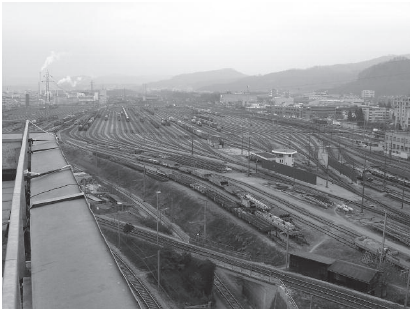
Abbildung 1: Blick Richtung Richtungsgruppe des Rangierbahnhofs von 1929. Rechts vorne werden die Güterwagen den Ablaufberg hinuntergestossen, im sechseckigen Stellwerk gebremst und in das richtige Gleis in der Richtungsgruppe gewiesen. (Bild: K. Elsasser)
