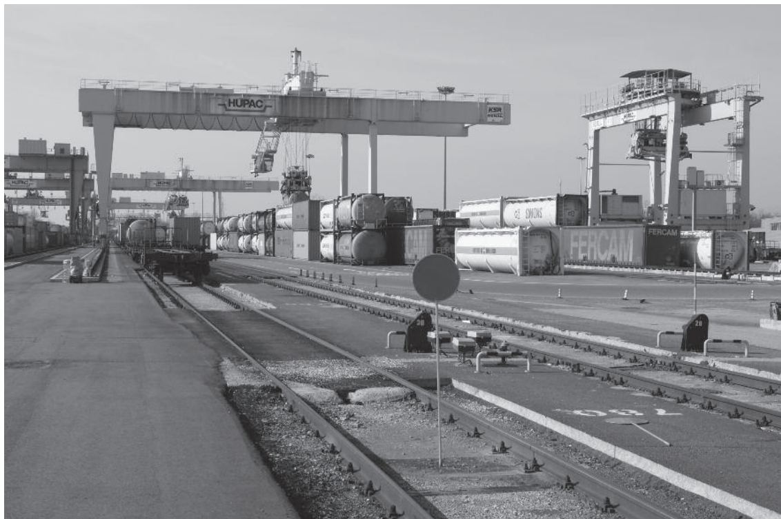
Abbildung 5: Im Computerterminal der HUPAC in Busto-Arizio bei Varese werden Wechselbehälter für den nächsten Transportschritt, beispielsweise die Feinverteilung auf einen Camion, umgeladen. (Foto: K. Elsasser)
