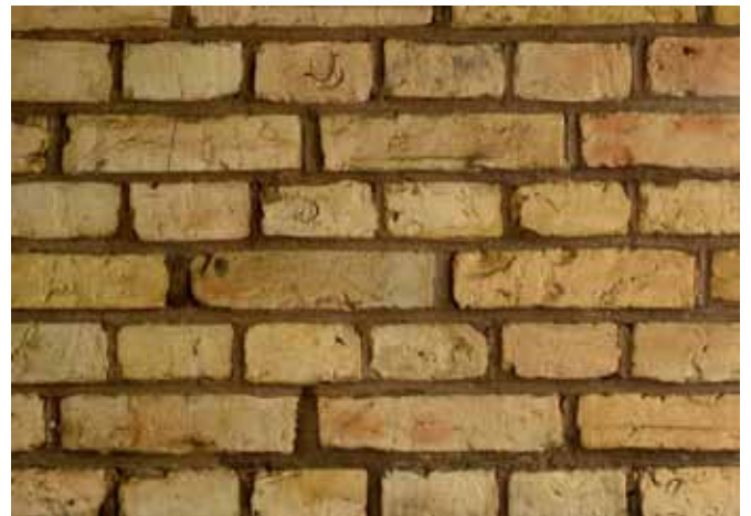
Abb. 11b Berlin, ehemaliges Königliches Leihamt. Relativ grobe Wasserstrichziegel aus Birkenwerder
