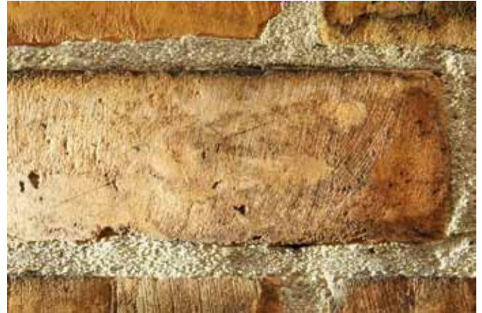
Abb. 7 Berlin, St.-Jacobi. Oberflächenstruktur eines Läufers im Streiflicht
