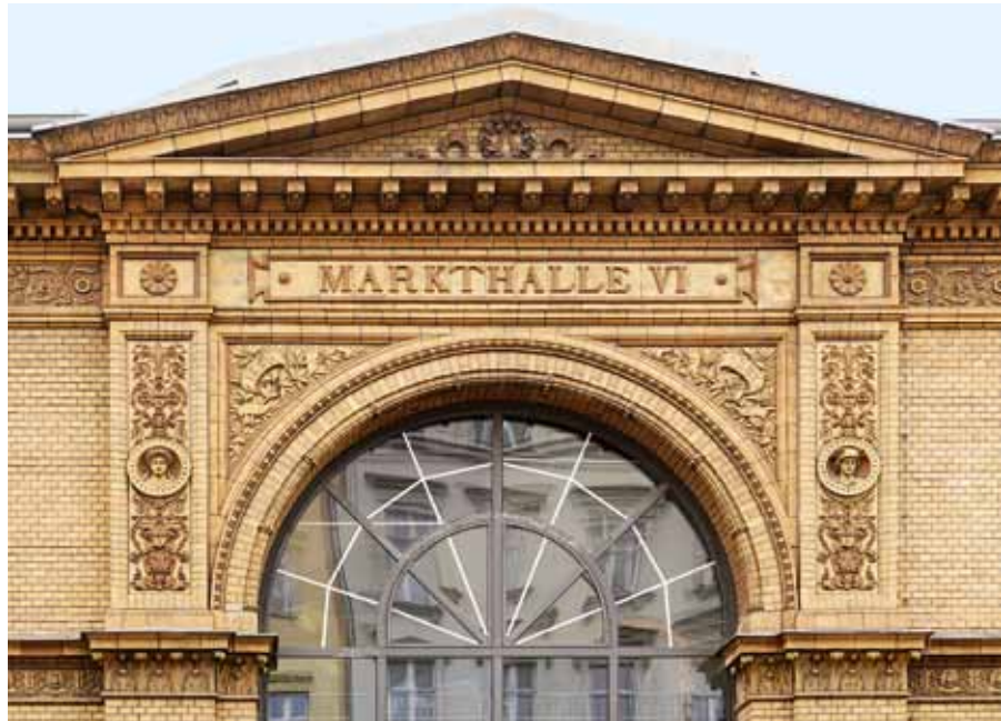
Abb. 25 (oben) Profilierte Sockelsteine und dekorierte Konsolen als Katalogware der Gröppinger Werke
