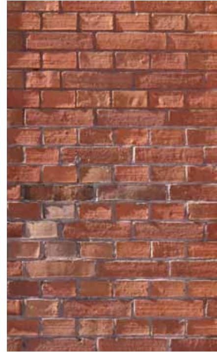
Abb. 16b Berlin, Rathaus. Horizontales Relief der Laubaner Langlochverblender
