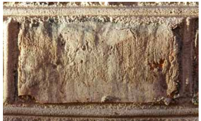
Abb. 5b Berlin, Friedrich-Werdersche Kirche. Handstrichziegel mit Spuren des Wasserstrichs und Kantenbeschnitt parallel zur Sichtfläche
