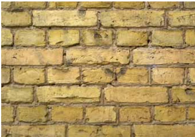
Abb. 10b Berlin, Bethanien. Relativ grobe Wasserstrichziegel aus Birkenwerder
