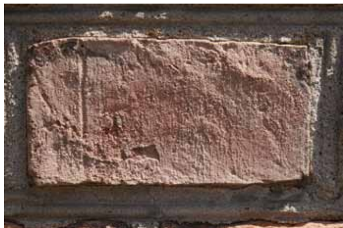
Abb. 3b Berlin, Nazarethkirche. Handstrichziegel mit Spuren des Wasserstrichs, Wulst und Schnittkante parallel zur Lagerfläche
