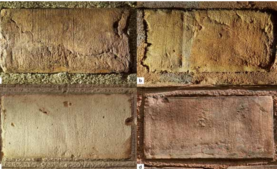
Abb. 8 Berlin, Verblendsteinbinder Stüler'scher Bauten unter Streiflicht. a) St.-Jacobi b) Anbau Johanniskirche c) St.-Matthäus d) St.-Bartholomäus
