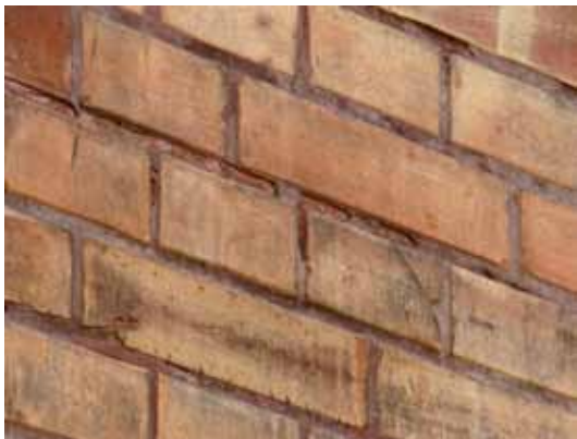
Abb. 17 (oben) Berlin, Anatomiegebäude. Horizontales Relief der Hermsdorfer Langlochverblender
