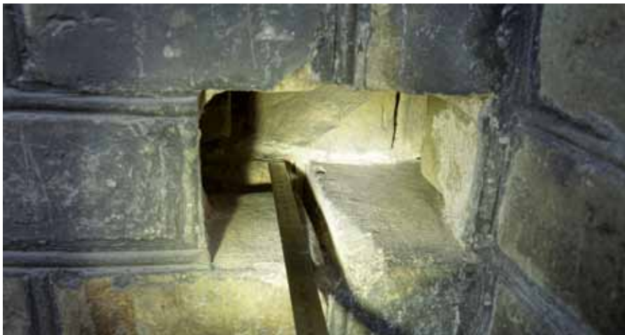
Abb. 15 Berlin, Stresow-Kaserne. \frac{1}{4} -Stein starke Hohlschicht
