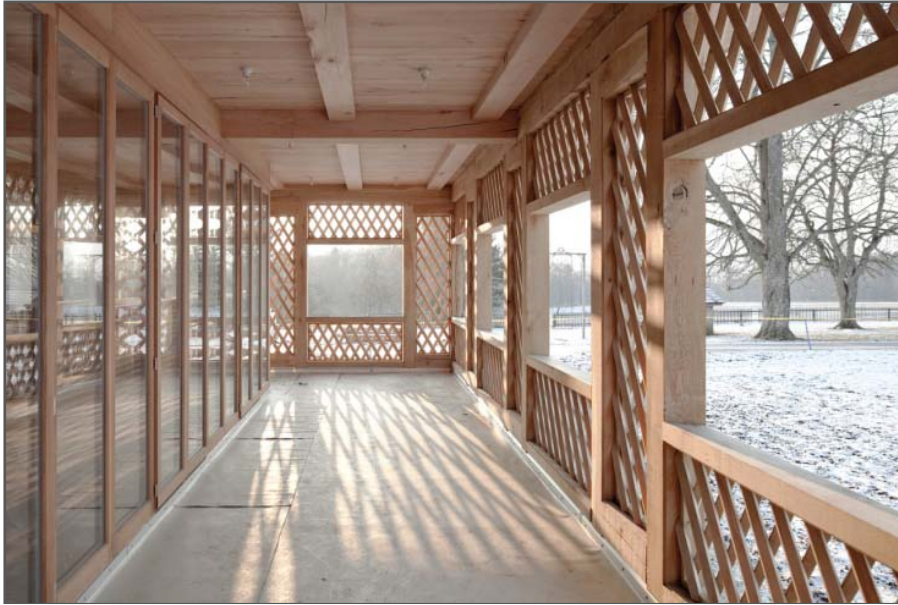
Abb. 3-3: Ferienhaus Büttenhardt mit angebohrten Tragbalken aus Eiche, Architektur: bernath+widmer (Roland Bernath)
