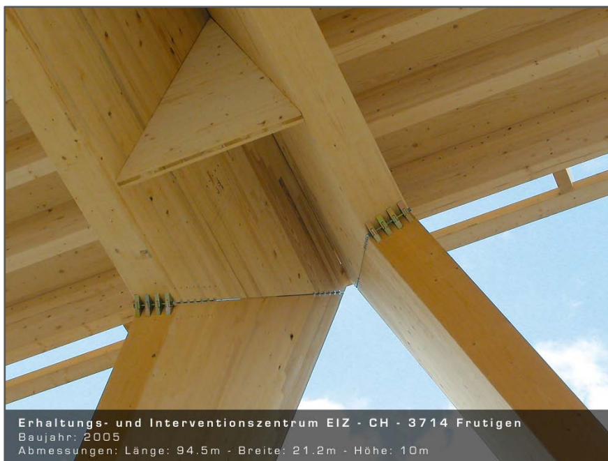
Abb. 3-21: Mit Esche verstärkter Eckanschluss der Neuen Holzbau AG (Neue Holzbau AG)
