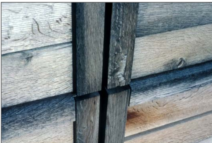
Abb. 3-9: Detailansicht der Eichenbretter der Fassade der BFH-AHB (Thomas Volkmer)
