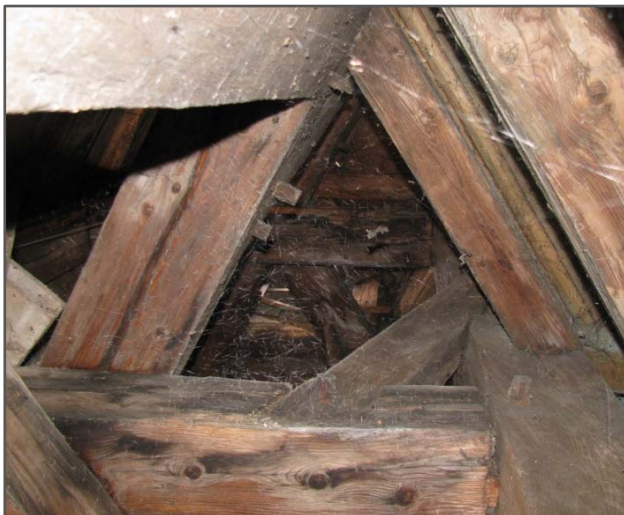
Abb.3-1: Blick in den Dachstuhl des Spittelturmes von Bremgarten mit Balken aus Eiche (Verena Krackler)
