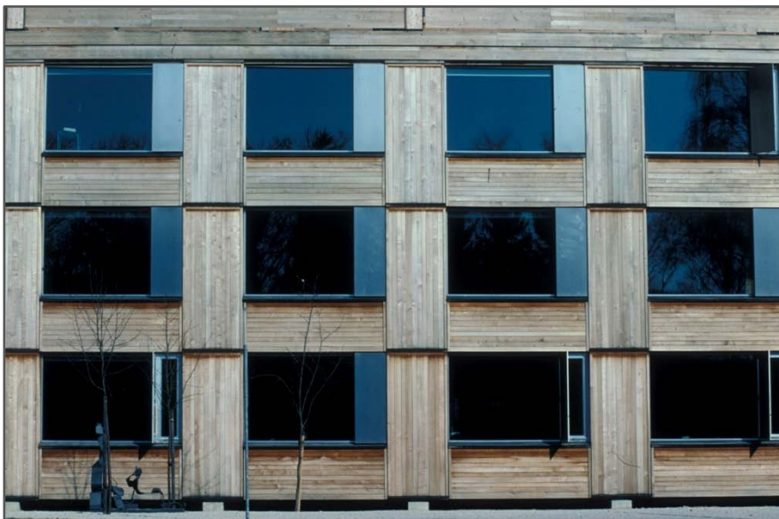
Abb. 3-8: Anordnung der Fassade aus Eichenbrettern der BFH-AHB (Thomas Volkmer)
