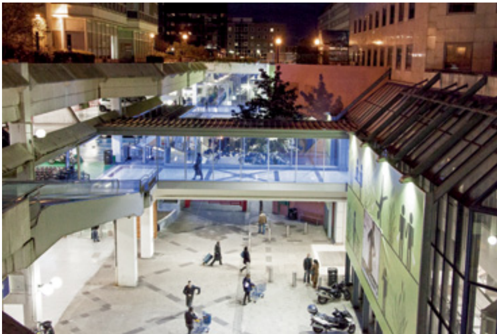
Übergang zwischen Parkhaus und Einkaufszentrum „Les Arcades“ Oktober 2012. Foto: AK
