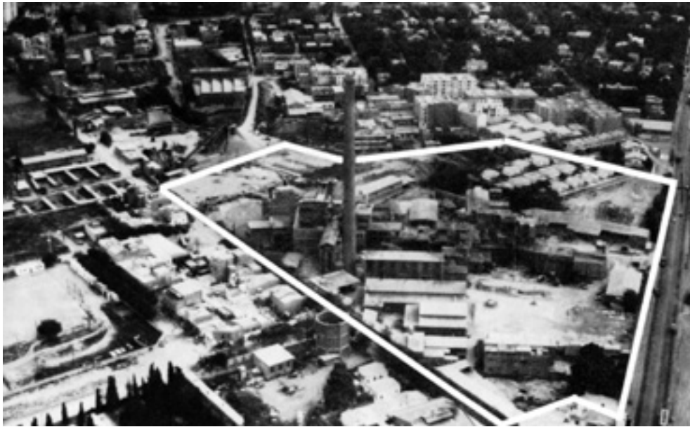
Luftbild des Standortes von Walden 7 vor Baubeginn
