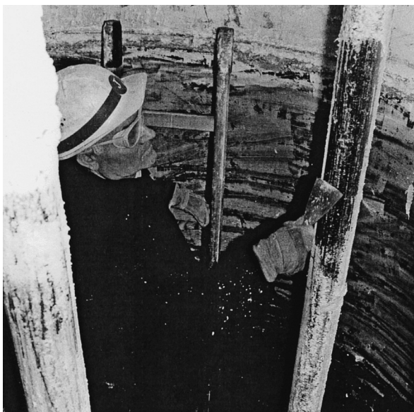
Abb. 20: Reinigung eines Autoklaven. Ernst 1974, 72.
