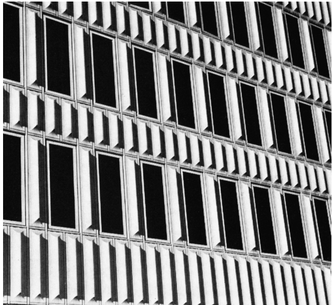
Abb. 22: «Fenster und Fassade dieses Bürogebäudes bestehen aus erhöht schlagzähem PVC.» Die 1970 gegenüber den Anfängen bei J. H. Benecke längst perfekt stabilisierten Oberflächenverkleidungen aus PVC konnten nicht verhindern, dass die Nachricht der VC-Kanzerogenität Kratzer auf dem Image des Kunststoffes hinterließ. Foto in: Kunststoffe , 60 (1970) 8, 532.
