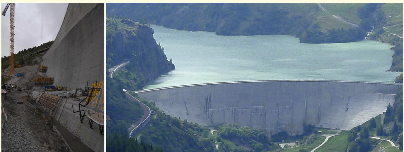
Bild 8. Erdbebenertüchtigung der Bogenstaumauer Les Toules im Wallis durch massiven Beton-Stützkörper auf der linken Talseiten (links) und mit den fertiggestellten Stützkörpern auf beiden Talseiten (rechts).
