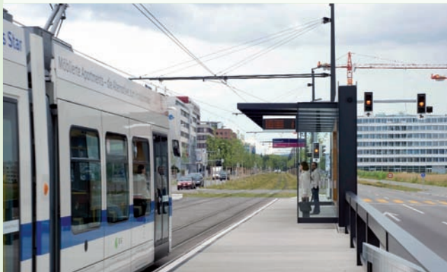
La ligne de la vallée de la Glatt dessert la zone de développement du nord de Zurich.
