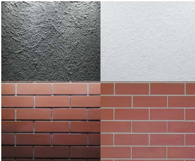
Abb. 3-21: Durch gerichtete Beleuchtung werden Strukturen deutlich sichtbar (links). Diffuse Beleuchtung (rechts) lässt diese verschwinden.
