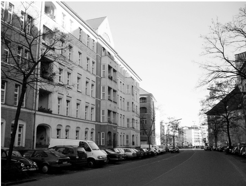
Wohnanlage am Rathaus Schöneberg, Blick in die Salzburger Strasse Richtung Rathausplatz
