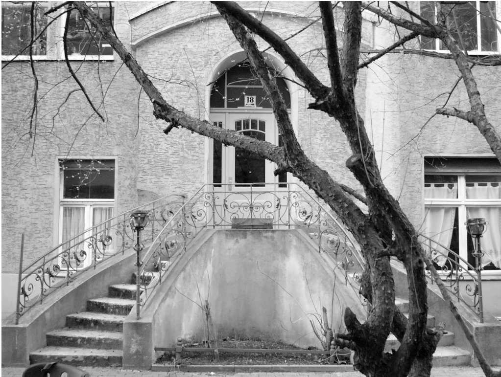
Goethepark, Detail eines Hauseingangs, heutiger Zustand
