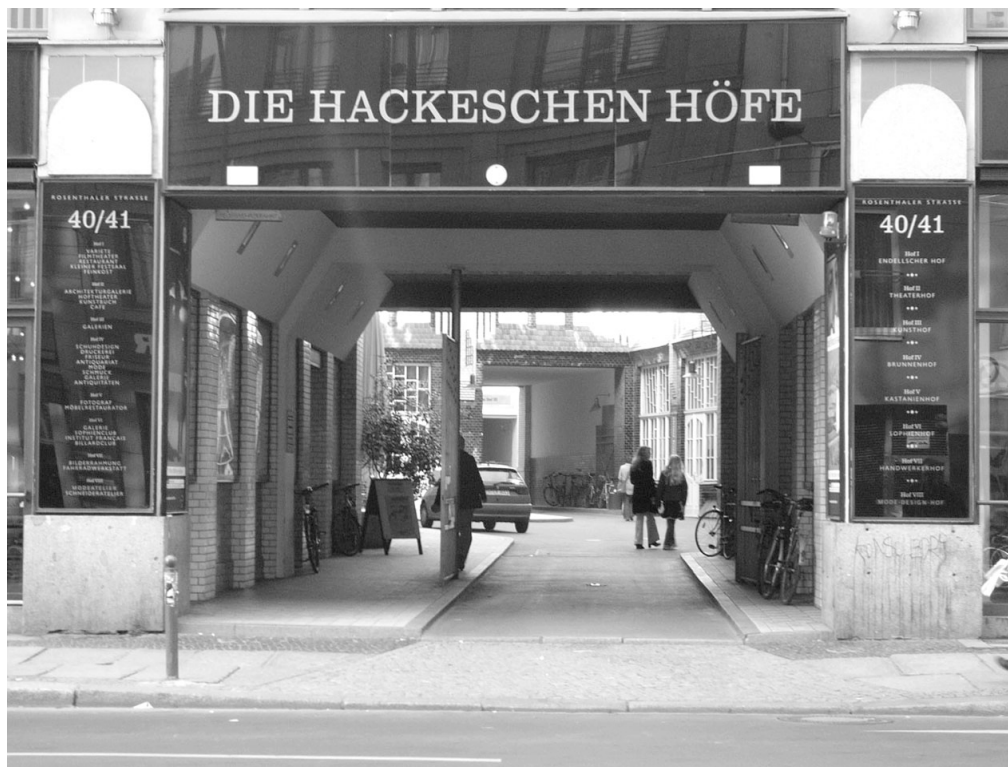
Hackesche Höfe (ehemals Hackescher Hof ), Durchgang an der Rosenthaler Strasse mit Blick in den Ersten Hof
