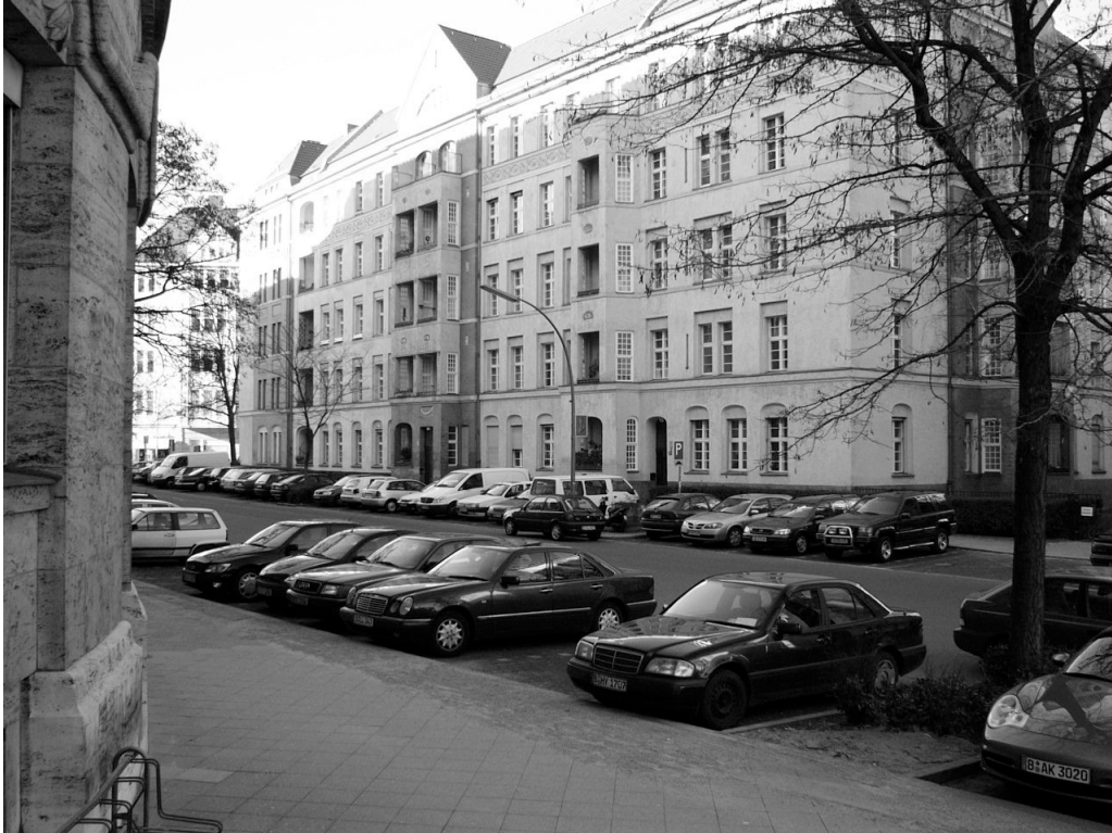
Wohnanlage am Rathaus Schöneberg, Blick in die Salzburger Strasse vom Rathausplatz
