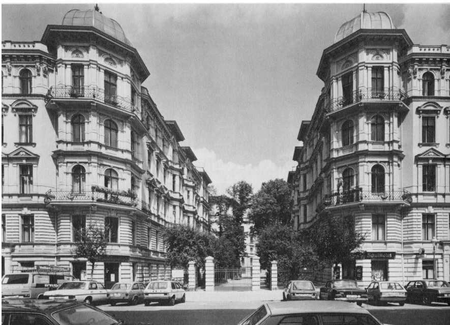
Riehmers Hofgarten, Portal an der Hagelberger Strasse
