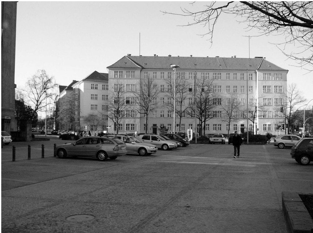
Wohnanlage am Rathaus Schöneberg, Blockfront am Rathausplatz, heutiger Zustand
