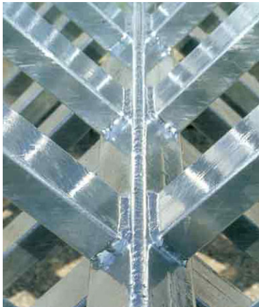
Bild (B018fueZ) geschweisste Stähle können durch Feuerverzinken langfristig vor Korrosion geschützt werden (Verzinkerei Stooss AG)
