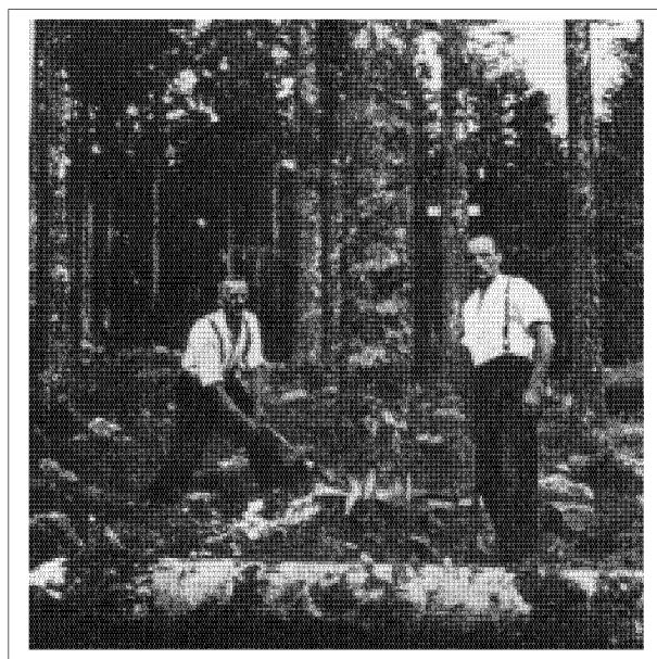
Abb. 58 Auf der Fallseite haut man eine Kärbe ein, um die Fallrichtung zu bestimmen. (Phleps, S. 39)
