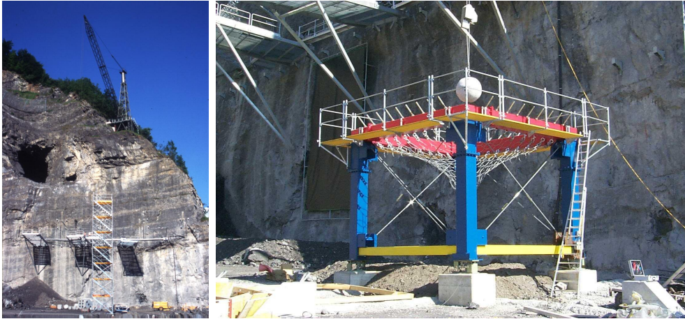
Abbildung 1.2: Grossversuchsanlage und Versuchsrahmen von SLF Davos und Fatzer AG Geobrugg Schutzsysteme
