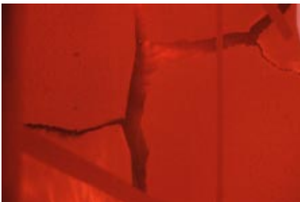
Abbildung D101 Foto Nr. 22 nach 92 Min.: Viele Risse in Fermacellplatte (5)
