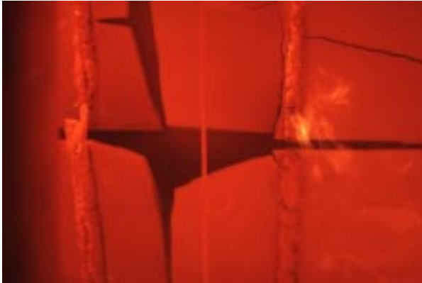
Abbildung D97 Foto Nr. 17 nach 72 Min.: Fermacellplatte (3) öffnet sich in der Mitte weiter
