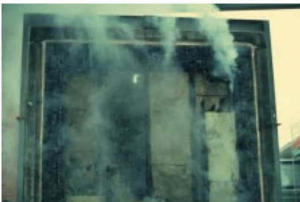
Abbildung D53 Wand 2 nach dem Brandversuch
