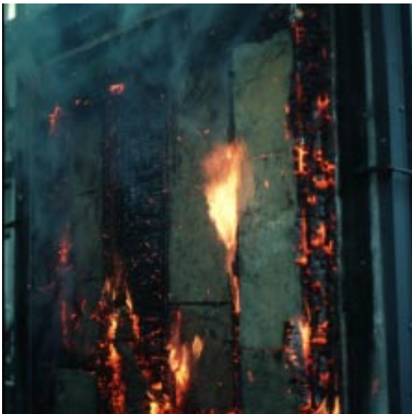
Abbildung D51 Wand 2 nach dem Brandversuch
