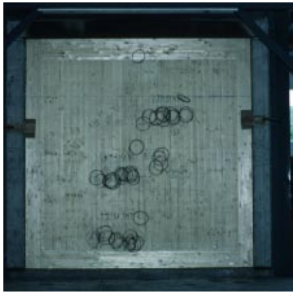
Abbildung D26 Wand 2 (Kaltseite)
