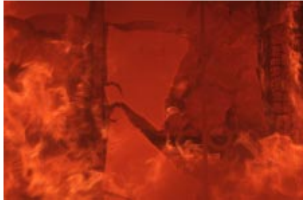
Abbildung D104 Foto Nr. 25 nach 111 Min.: Pavathermplatte (6) Mitte links dem Feuer direkt ausgesetzt
