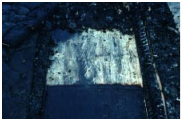
Abbildung D24 Wand 1 nach dem Brandversuch
