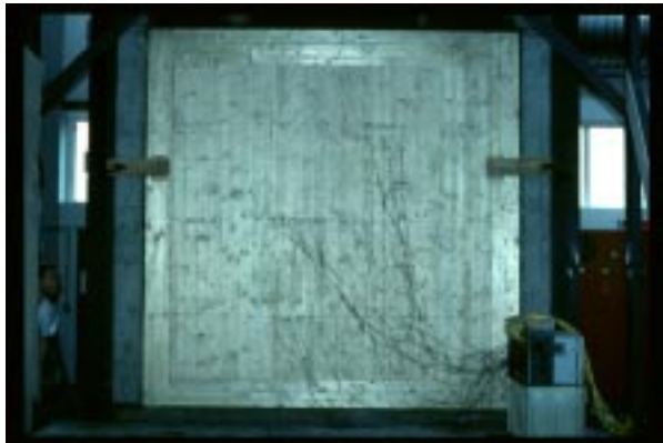
Abbildung D79 Wand 4 (Kaltseite)
