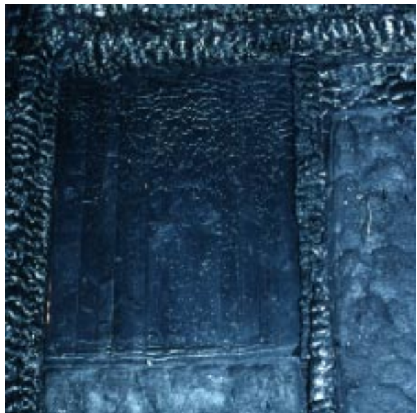
Abbildung D22 Wand 1 nach dem Brandversuch
