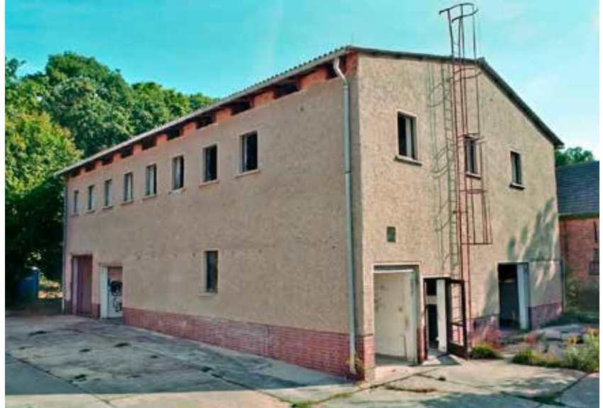
Situación existente / Existing situation © Paul Reinhardt
