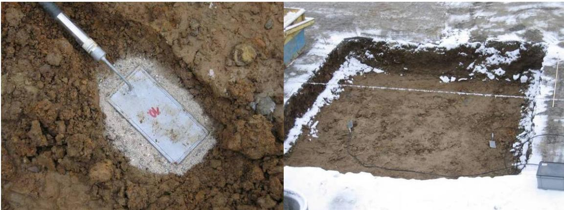
Abb. 5.10: Links: Einbau des Druckkissens auf eine Schicht Grobsand. Rechts: Positionierung der Druckkissen in der Fundamentvertiefung Nr. 1
