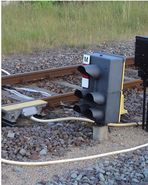
Abbildung 8.5 Hauptsignal in Bauform eines Zwergsignals (Bereich ehem. Deutsche Reichsbahn)
